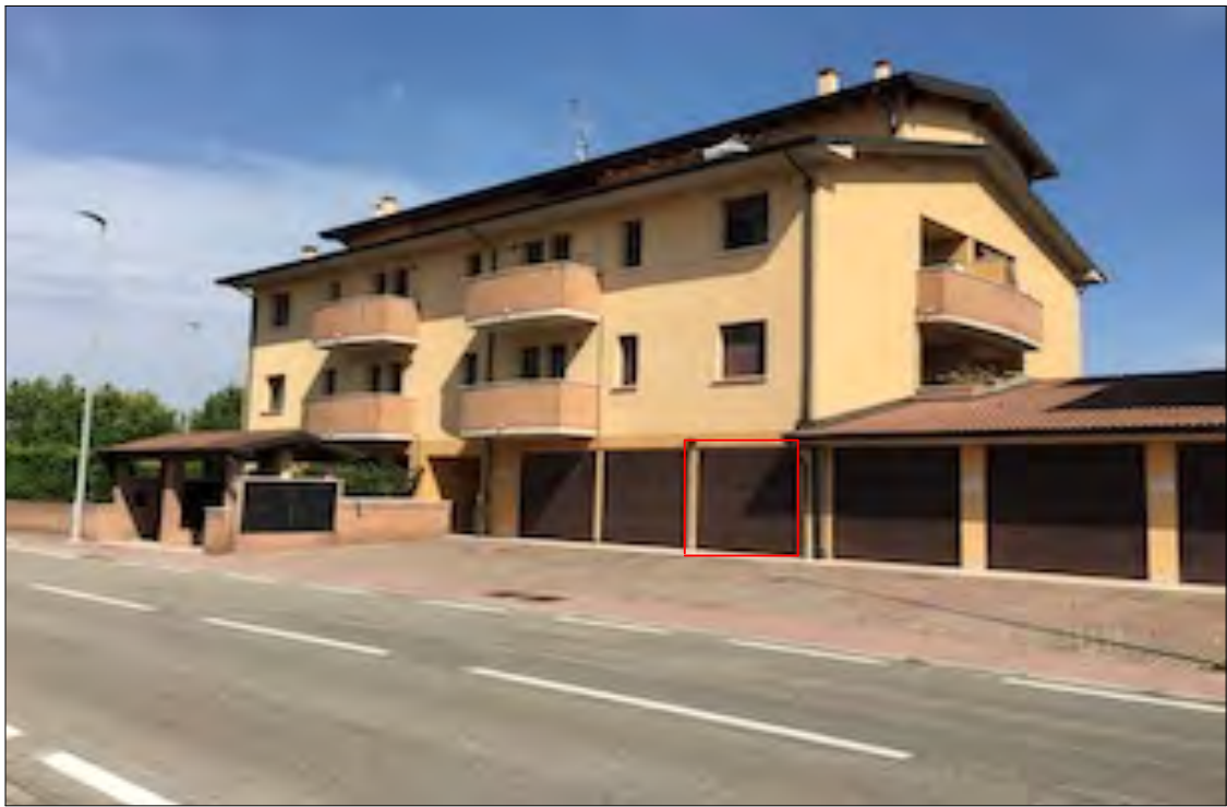
Lotto 7 fotografia n° 3 - ripresa ingresso condominiale da Via Caravaggio
