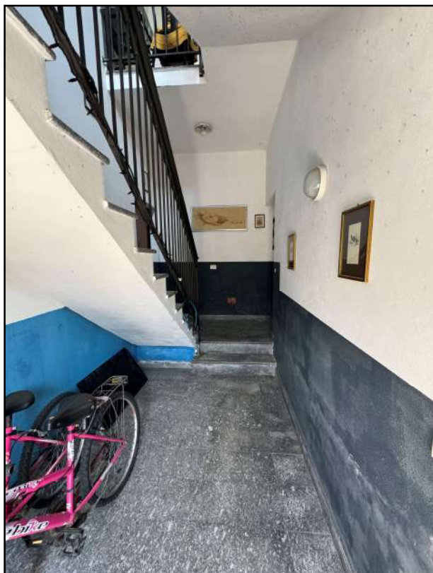
Foto 3: Il vano scala.
