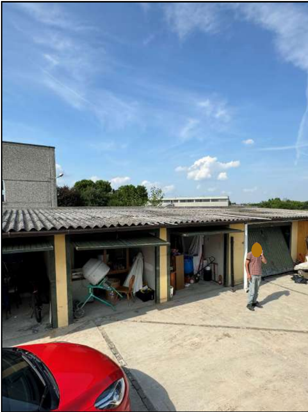
Foto 17: Il fabbricato in cui è inserita l'autorimessa pignorata.
