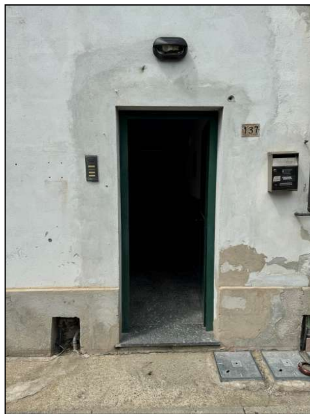
Foto 2: La porta di accesso all'immobile pignorato.
