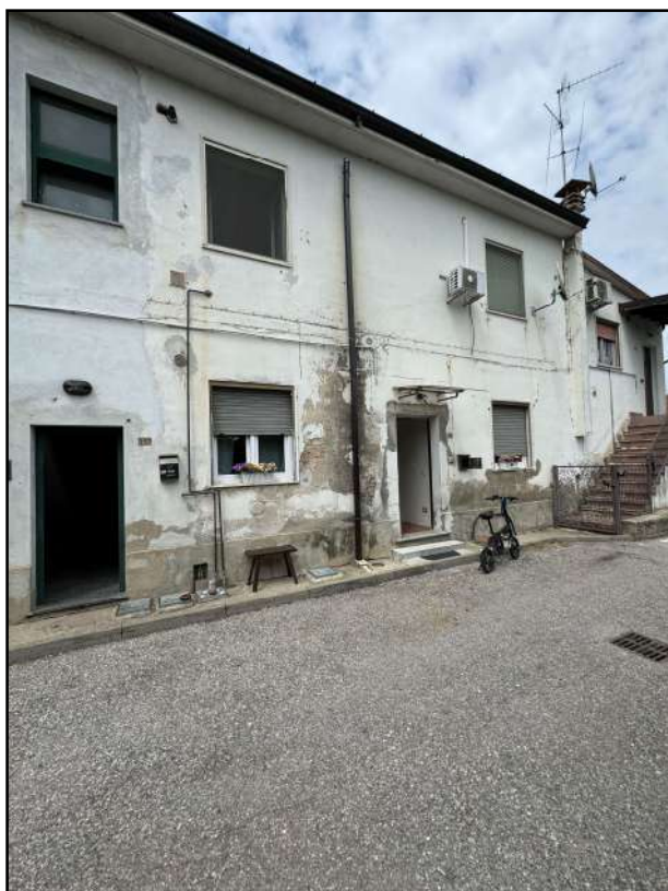
Foto 1: Prospetto del fabbricato nel quale è inserito l'immobile pignorato.
