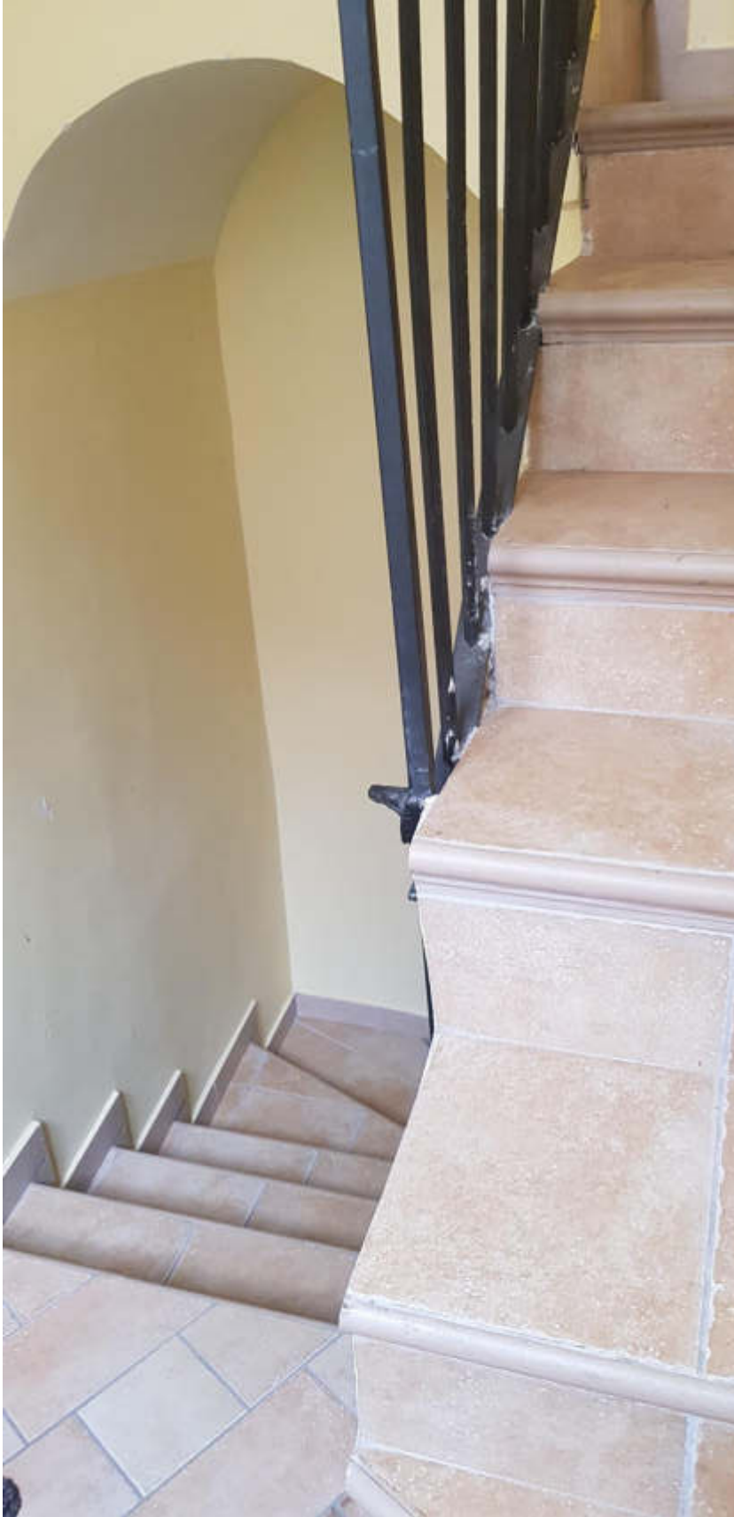
Vano scale condominiale
