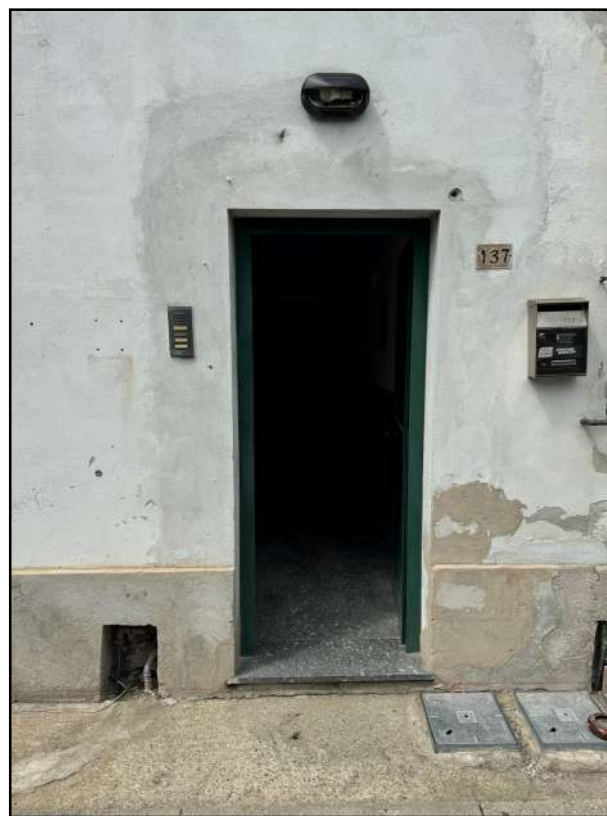
Foto 2: La porta di accesso all'immobile pignorato.
