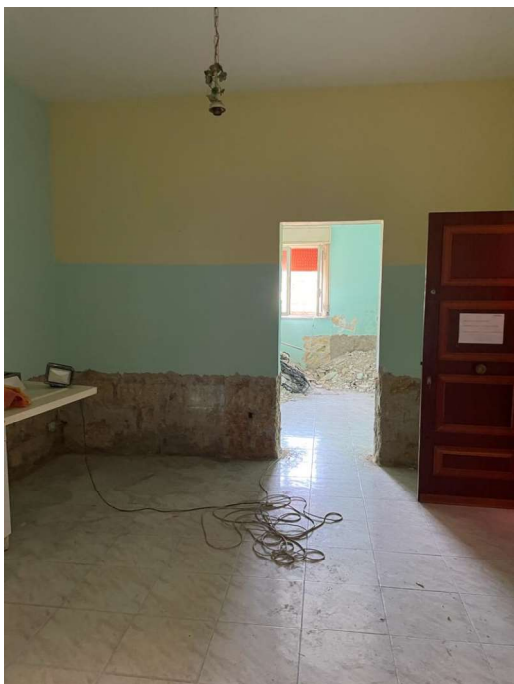
Foto n. 3 – interni – vano 1 ed accesso al vano 2
