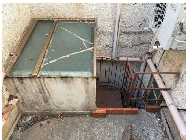
Foto n. 7 – corte esterna posta al 1° piano
