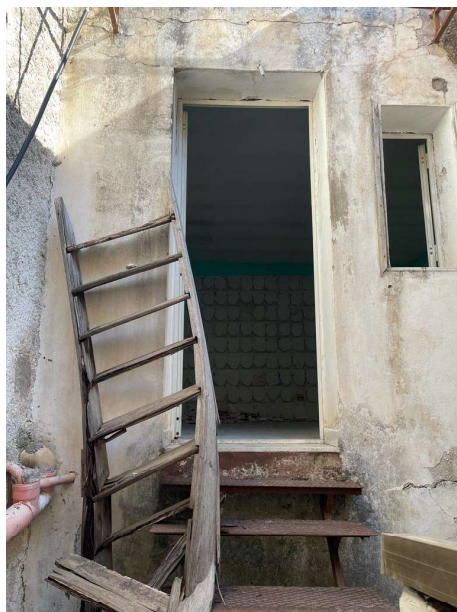
Foto n. 8 – accesso al vano 5 – 1° piano
