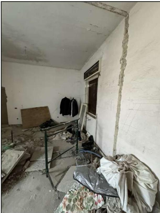
**Foto 11:** La seconda camera da letto, ampliata rimuovendo i muri del bagno, ora non più esistente.
