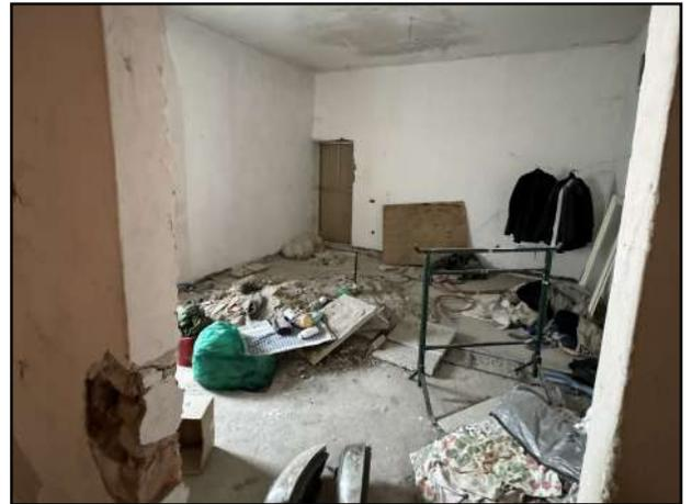
**Foto 10:** La seconda camera da letto, ampliata rimuovendo i muri del bagno, ora non più esistente.
