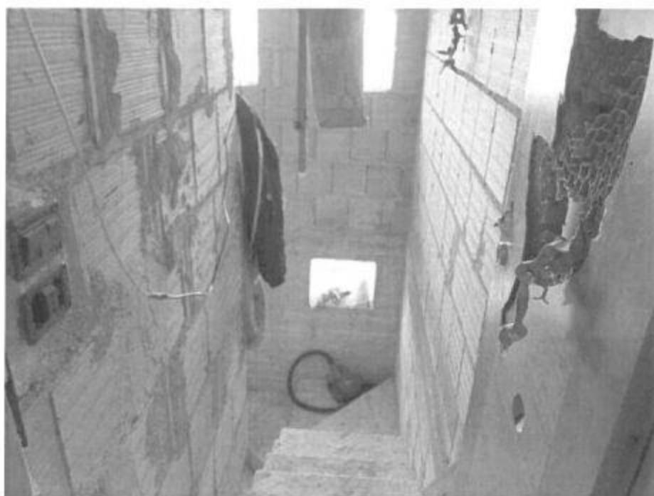
Foto n. 10 – Vico viro scala interno – appartamento P 1
