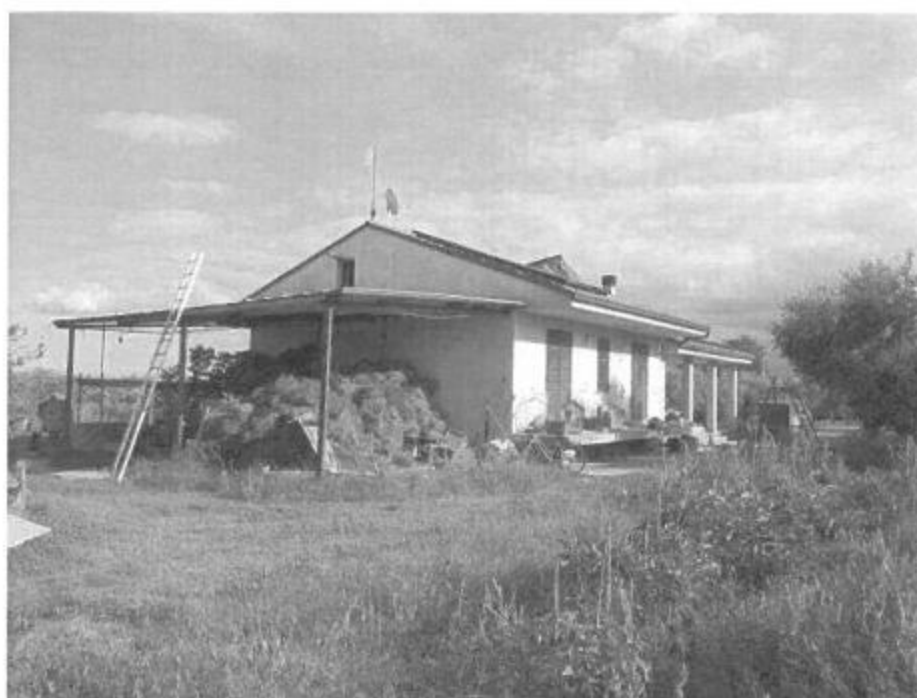
Foto n. 5 – Vista posteriore del fabbricato e della tettoia non autorizzata
