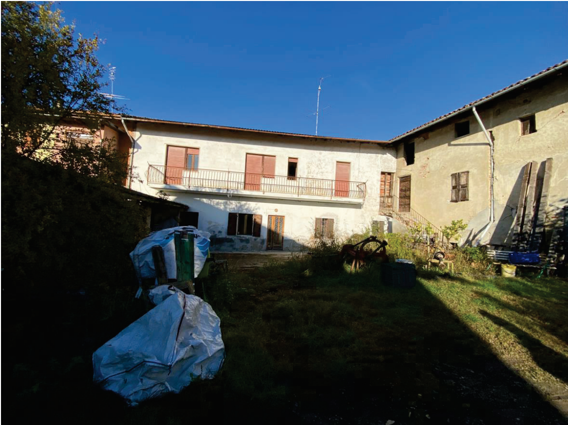
FOTO 2 : VISTA ESTERNA LATO CORTILE INTERNO
