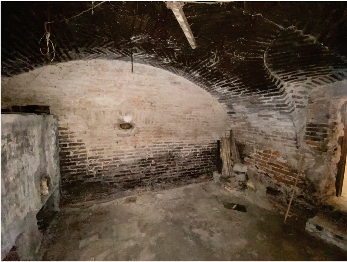
FOTO 7 : VISTA INTERNA CANTINA PIANO TERRENO
