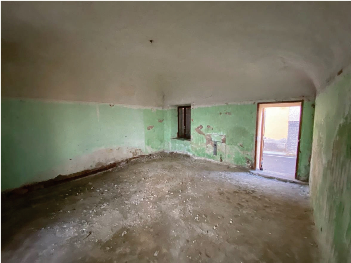
FOTO 4 : VISTA INTERNA SOGGIORNO PIANO TERRENO
