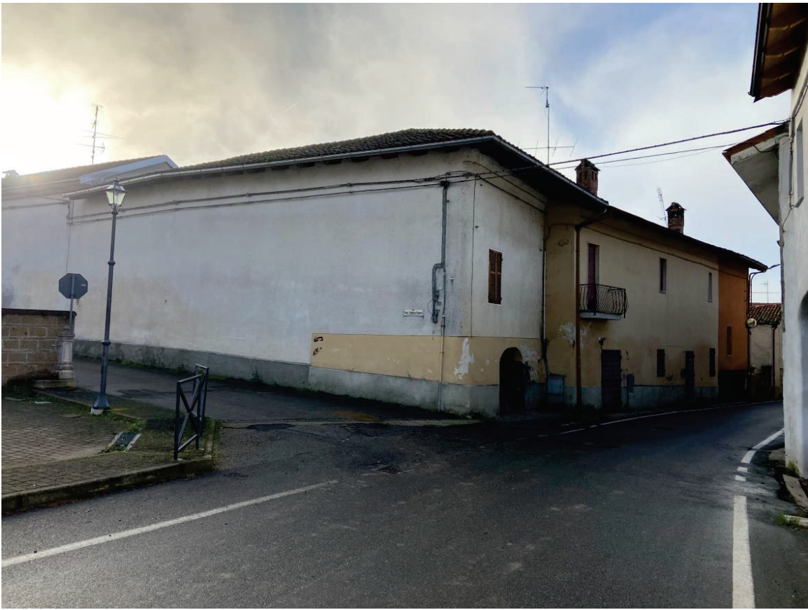
FOTO 1 : VISTA ESTERNA DALLA VIA PUBBLICA
