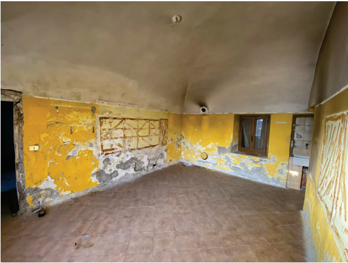
FOTO 5 : VISTA INTERNA CUCINA PIANO TERRENO
