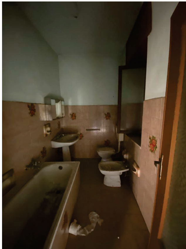
FOTO 12 : VISTA INTERNA BAGNO PIANO PRIMO
