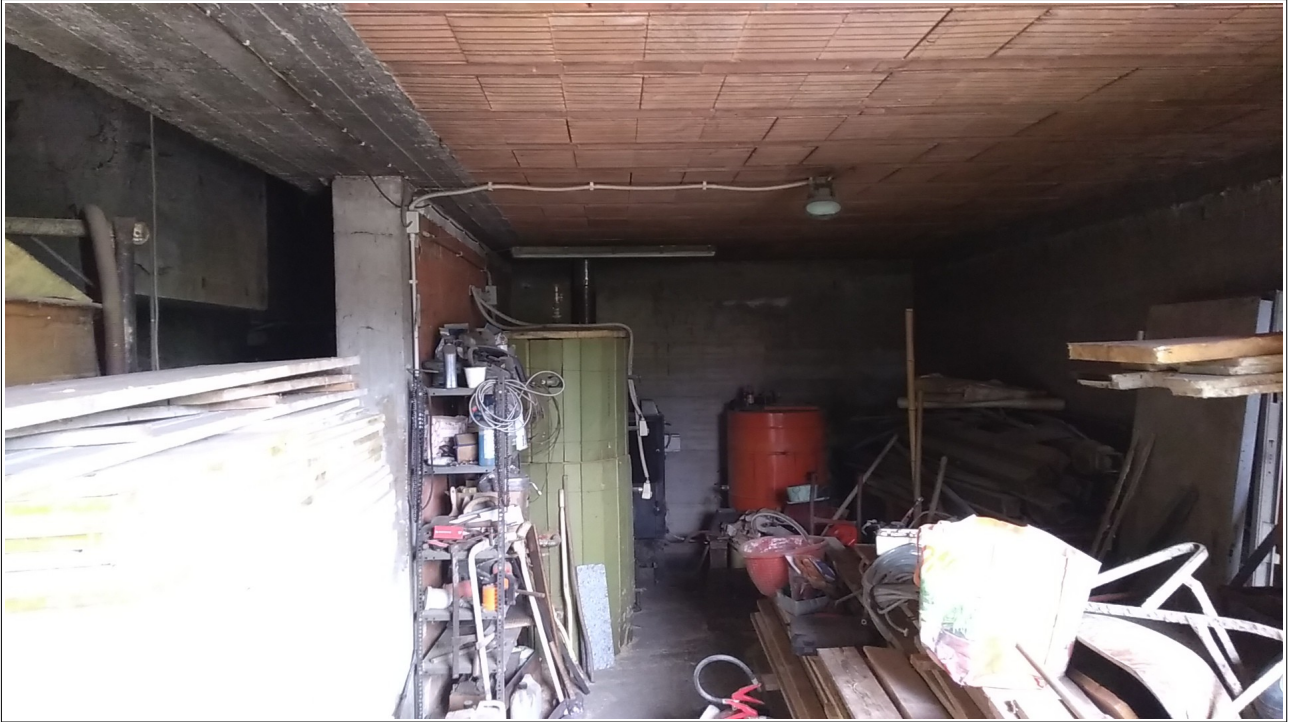
Interno ampliamento abusivo ad uso deposito (piano seminterrato)
