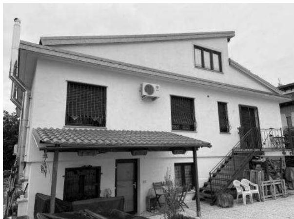
Vista interna lato cortile
