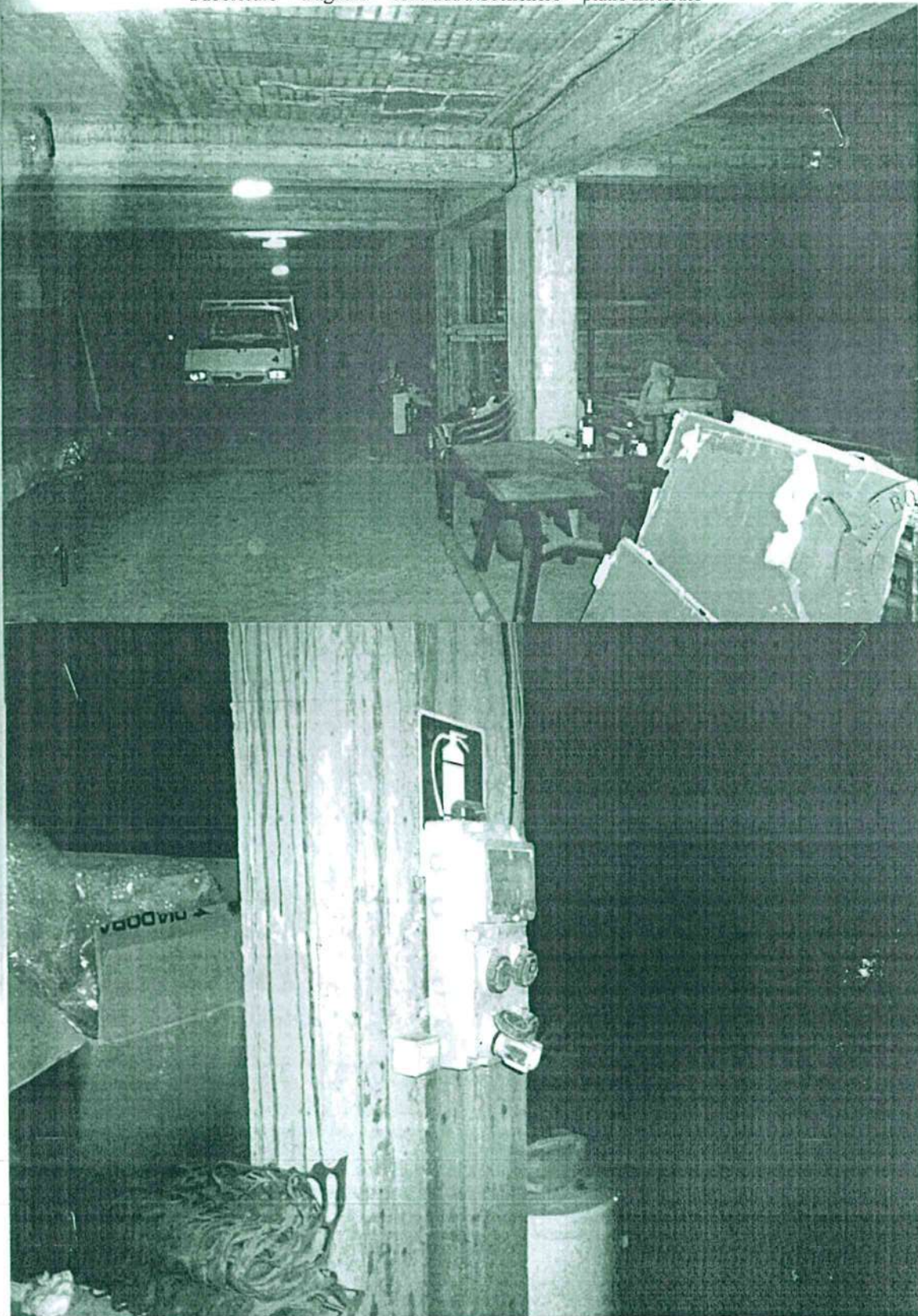
Foto n°84-85 Fabbricato – Pagliara – contrada Rocchenere – piano interrato
