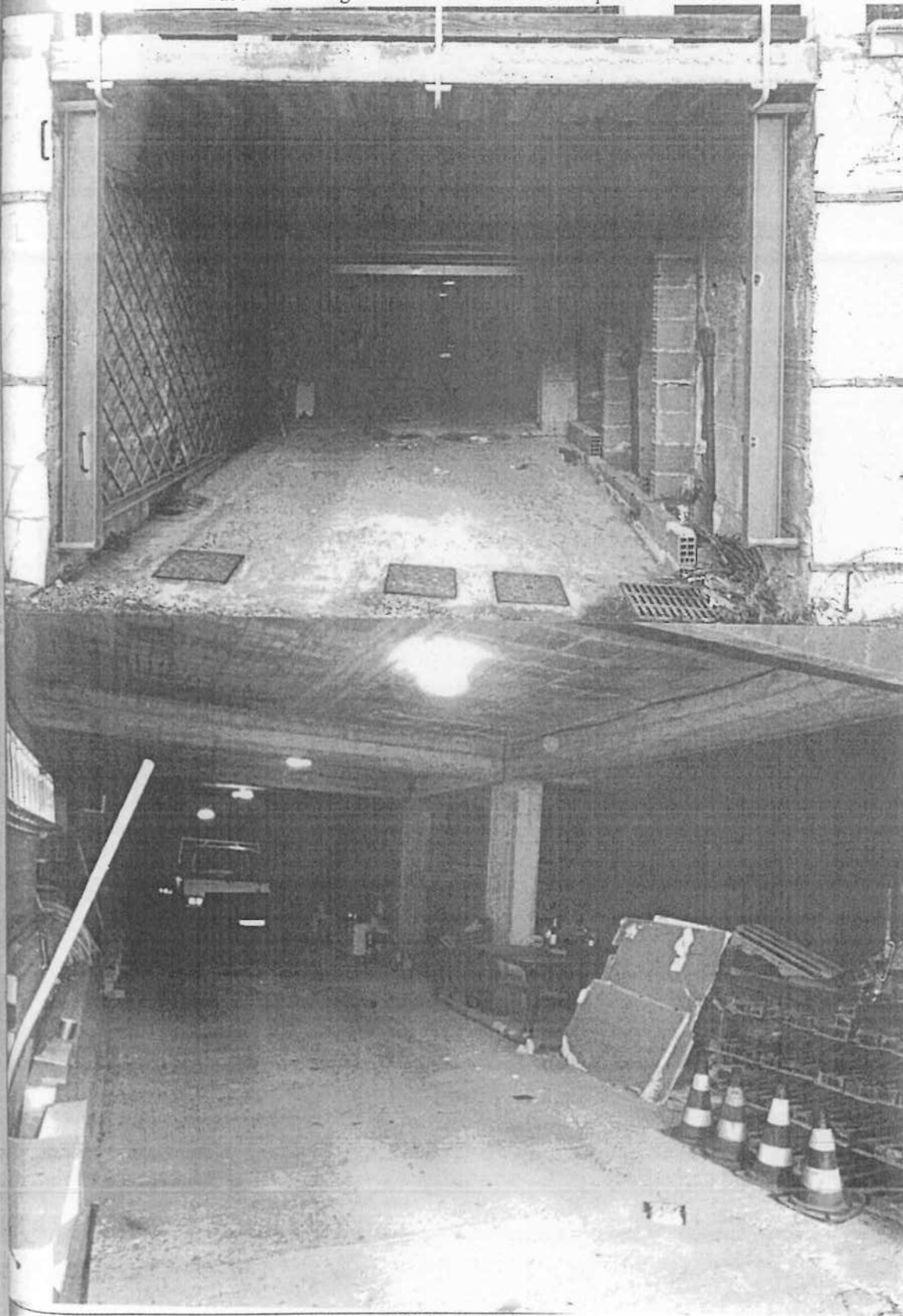
Foto n°82-83 Fabbricato - Pagliara - contrada Rocchenere - piano interrato
