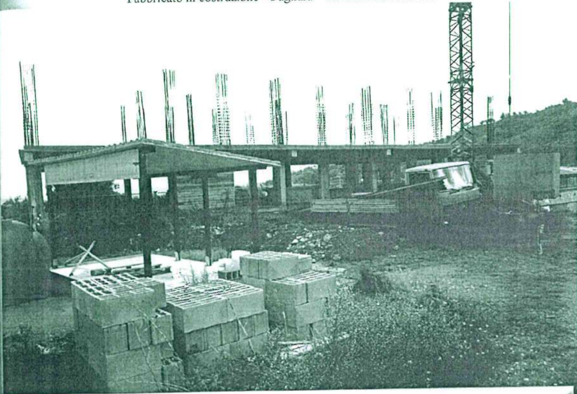
Foto n°80-81 Fabbricato in costruzione – Pagliara – contrada Rocchenere
