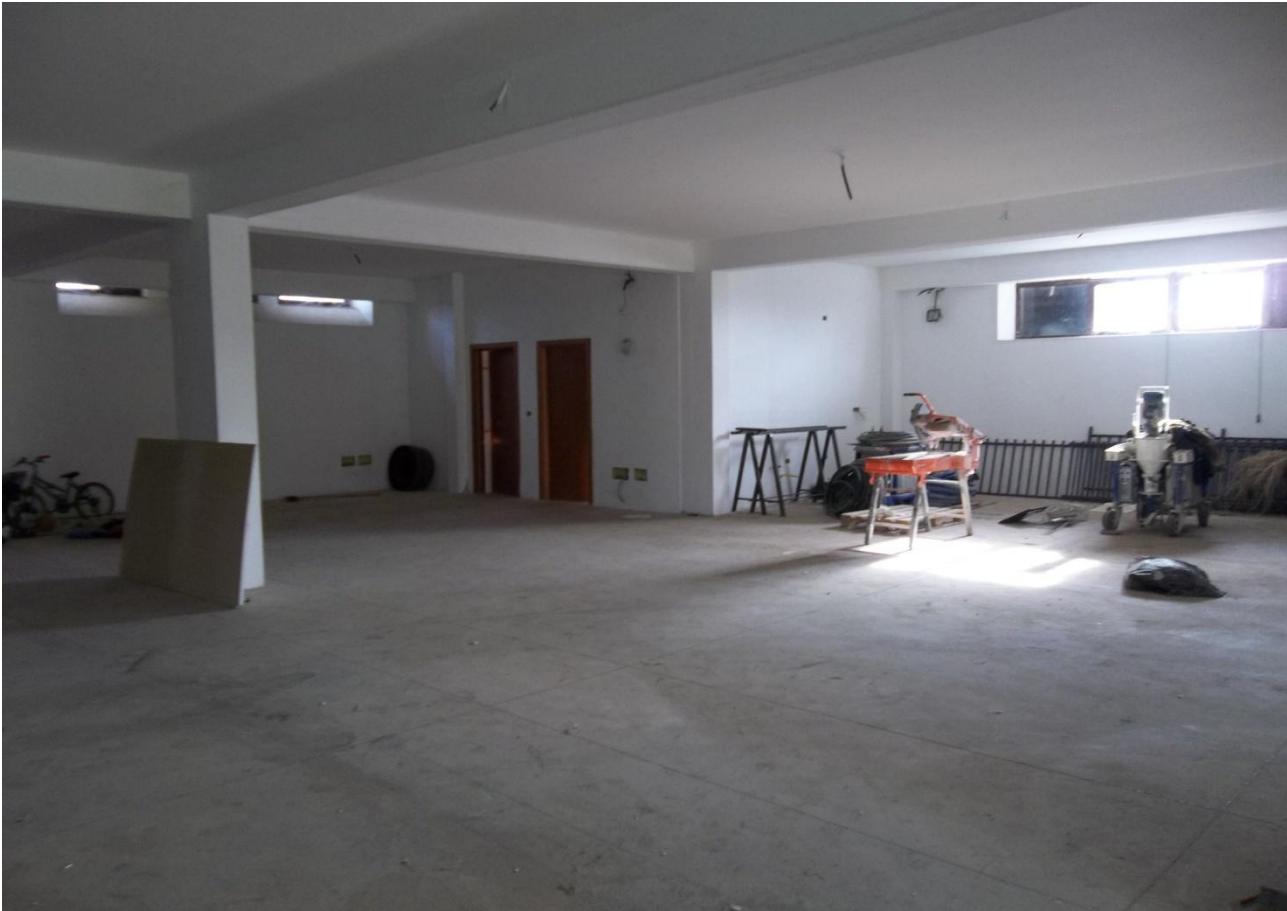
Foto 7 – Particolari interni locale garage/deposito
