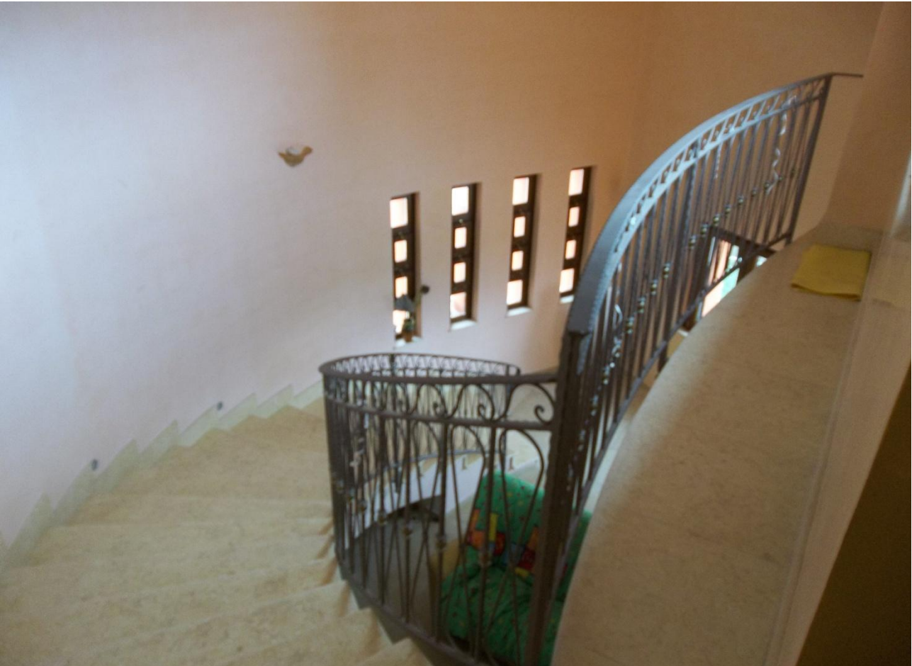
Foto 13 – Particolari interni alloggio – scala a giorno –
