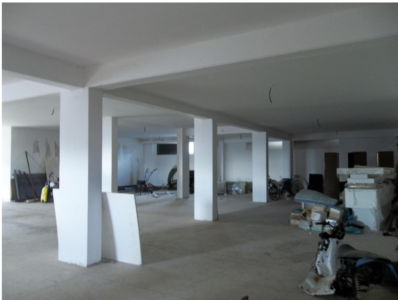
Foto 9 – Particolari interni locale garage/deposito
