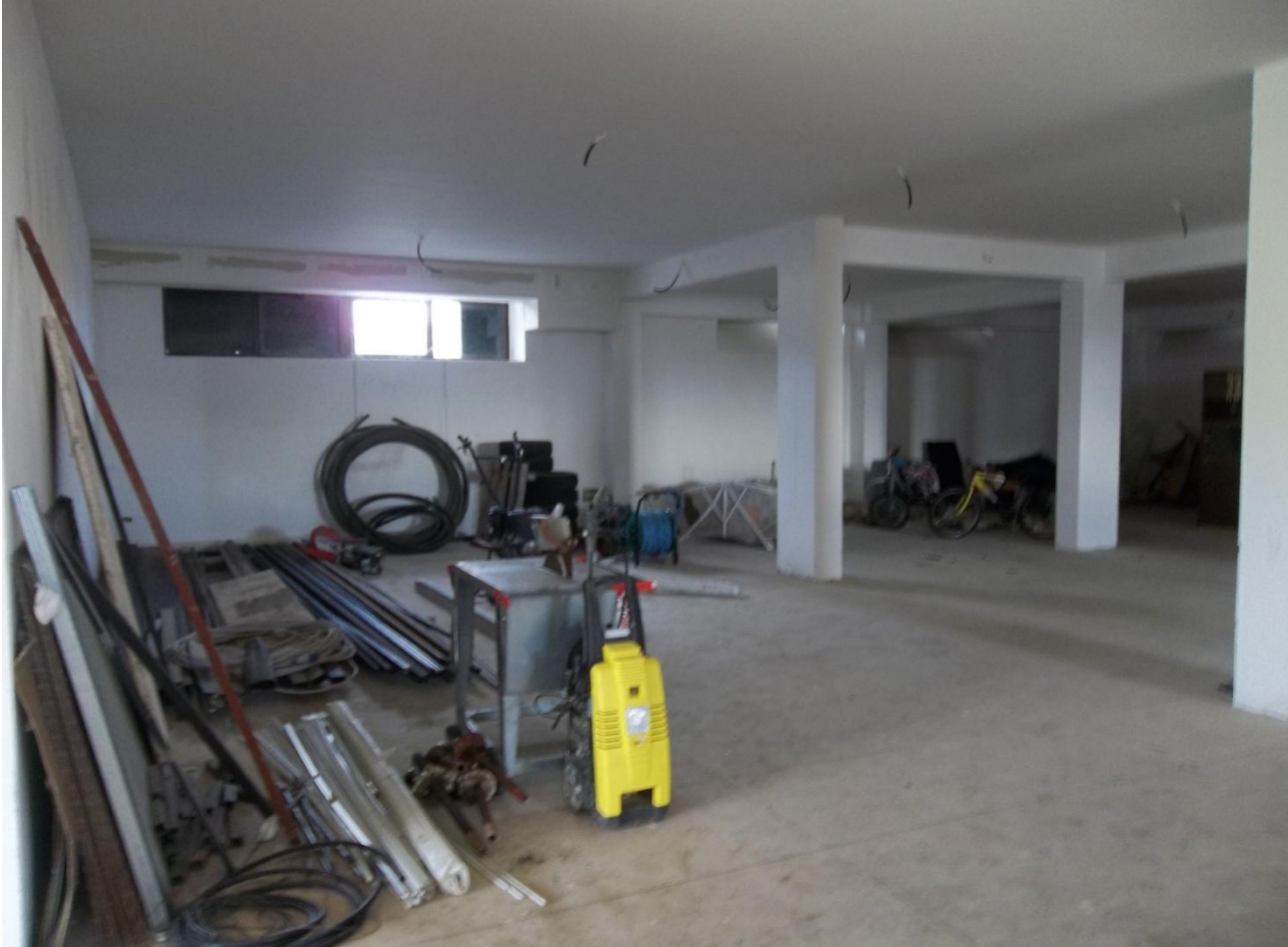
Foto 8 – Particolari interni locale garage/deposito
