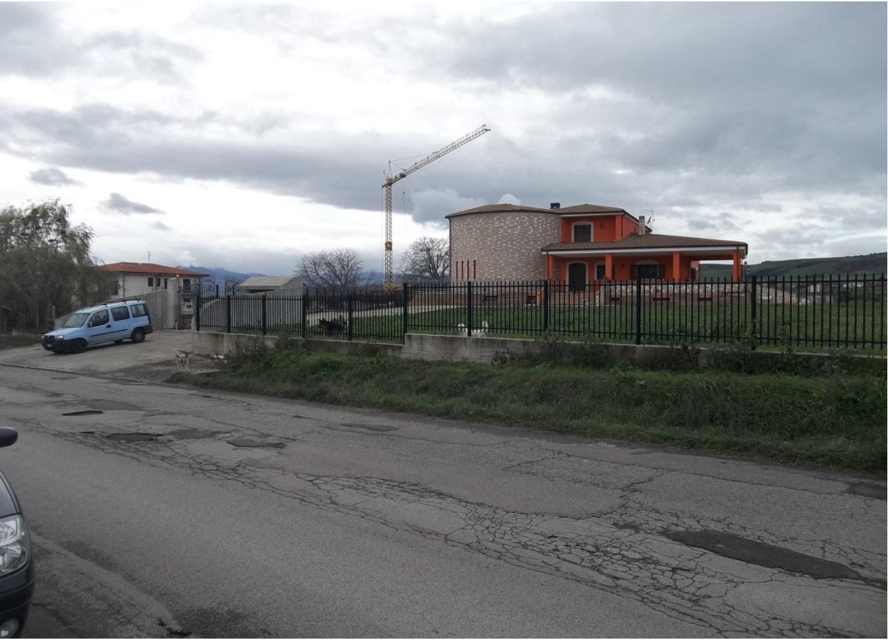
Foto 2 – Accesso agli immobili
