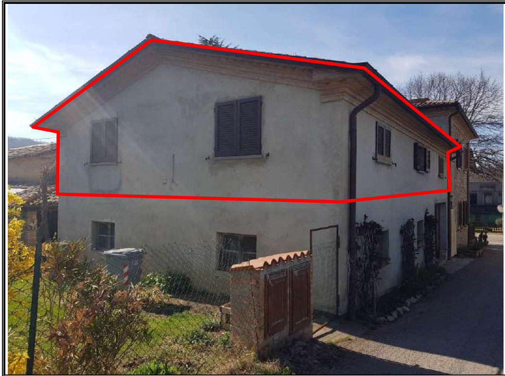
Foto n. 3 Vista esterna del fabbricato di cui l'immobile pignorato (perimetrato in rosso) fa parte.
