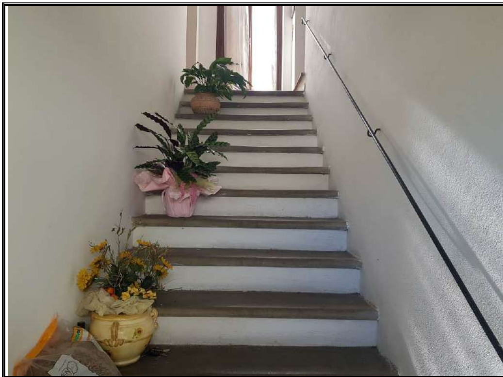
Foto n. 5 Scala che conduce all'immobile pignorato.
