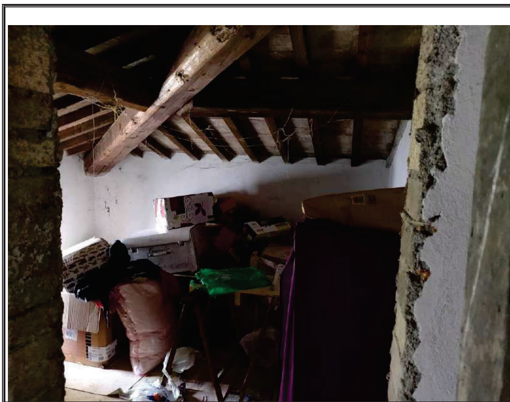
Foto n. 28 Piano secondo – soffitta (part. 194).
