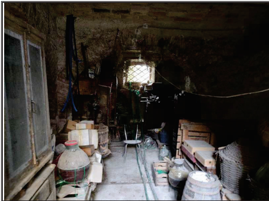
Foto n. 7 Cantina posta al piano primo sottostrada.
