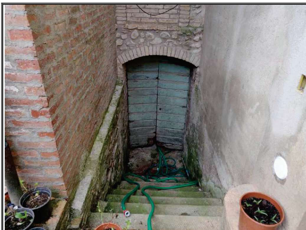
Foto n. 6 Scada e porta di accesso alla cantina posta al piano primo sottostrada.
