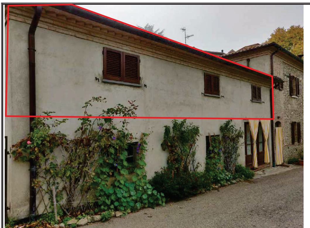
Foto n. 4 Vista esterna del fabbricato di cui gli immobili pignorati fanno parte. La porzione perimetrata in rosso posta al piano primo è stata oggetto di stima relativa alla procedura n. 158/2018.
