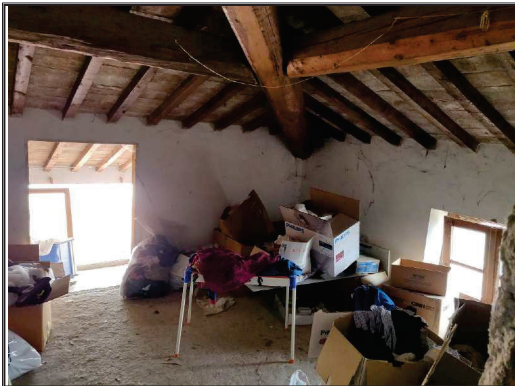
Foto n. 27 Piano secondo – soffitta (part. 194).
