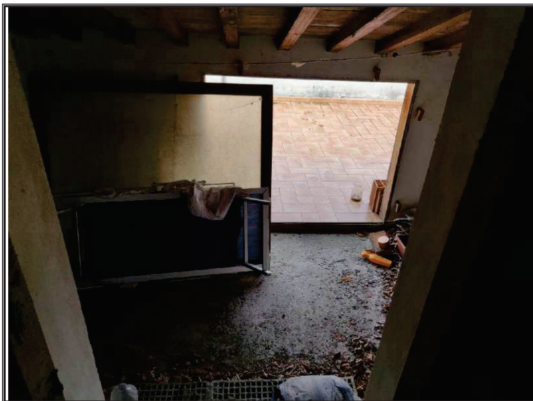
Foto n. 29 Piano secondo – soffitta (part. 48/7).
