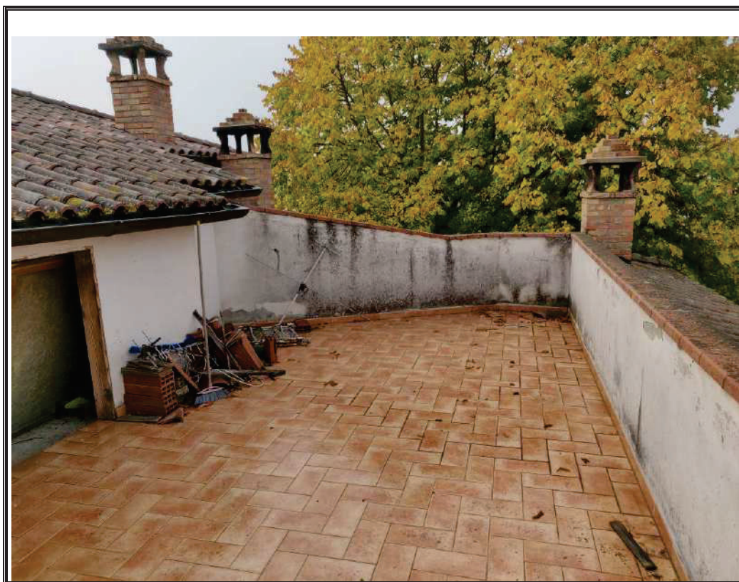
Foto n. 30 Piano secondo – terrazzo (part. 48/7).
