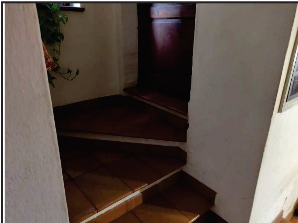
Foto n. 13 Rampa della scala di accesso alle camere del piano terra.
