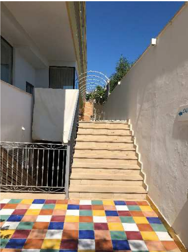
Foto 44: Vista area esterna
