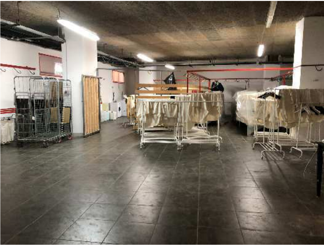
Foto 43: Vista deposito al piano cantinato
