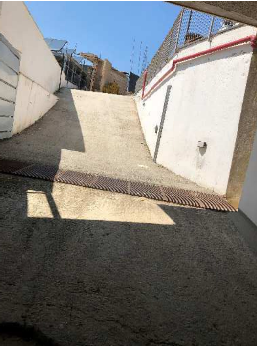
Foto 41: Vista ingresso a piano cantinato
