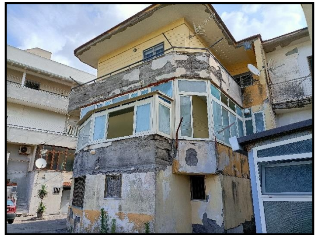
VISTA PROSPETTO OVEST
