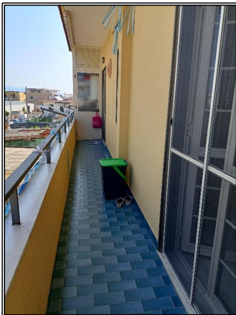
Balcone (lato nord)
