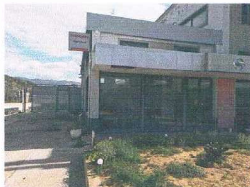
FOTO N. 7 PORTA SCORREVOLE DA RIMUOVERE
