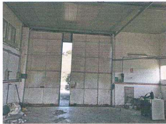
FOTO N. 4 PORTE D'INGRESSO INTERNO
