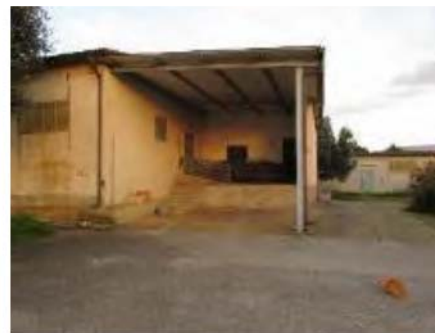
Foto n.°14 Particolare tettoia di accesso
