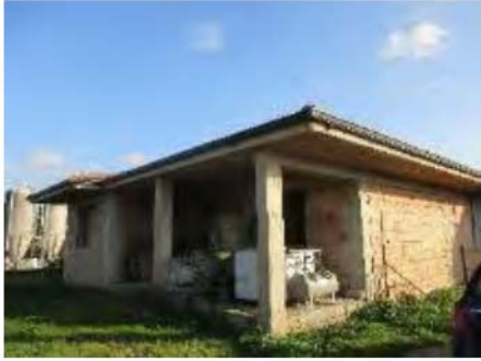
Foto n.°1 – Ingresso – Prospetto nord
