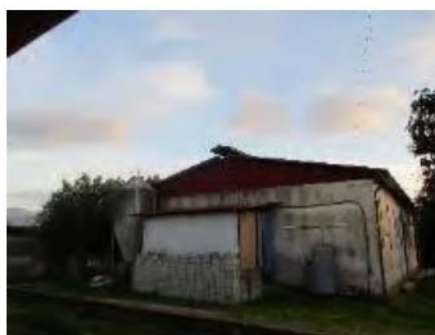
Foto n.°12 Prospetto nord
