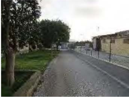
Foto n.°27 Corte esterna pavimentata
