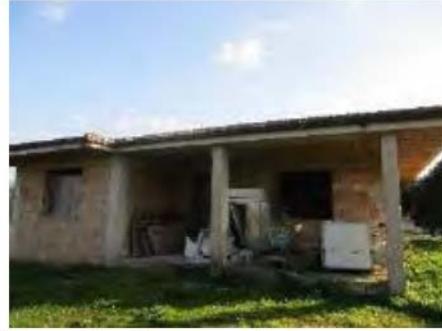
Foto n.°2 – Ingresso – Lato nord
