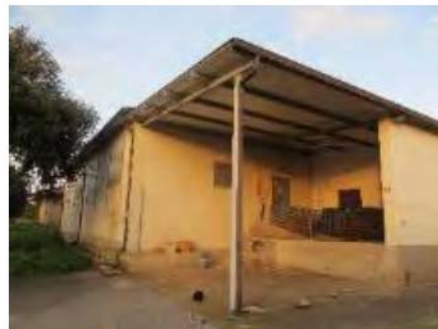
Foto n.°10 Prospetto ovest
