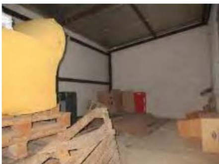
Foto n.°15 Particolare deposito
