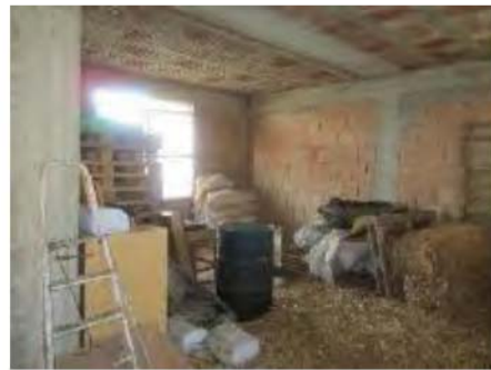
Foto n.°6 Particolare interno
