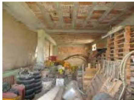
Foto n.°8 Particolare interno
