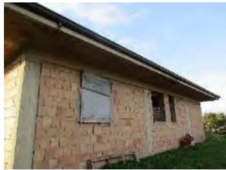
Foto n.°4 Prospetto ovest
