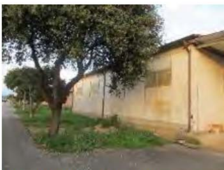
Foto n.°11 Prospetto ovest
