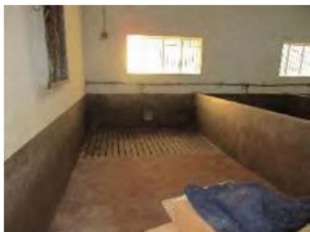
Foto n.°17 Particolare box
