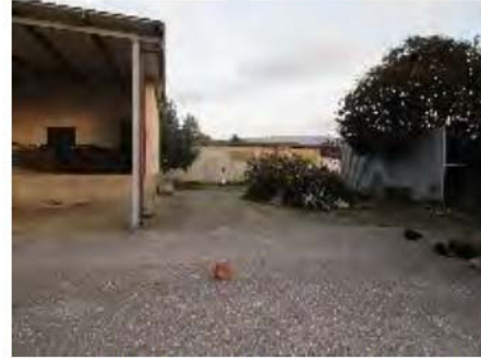
Foto n.°28 Corte esterna pavimentata
