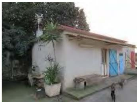
Foto n.°21 Particolare prospetto nord
