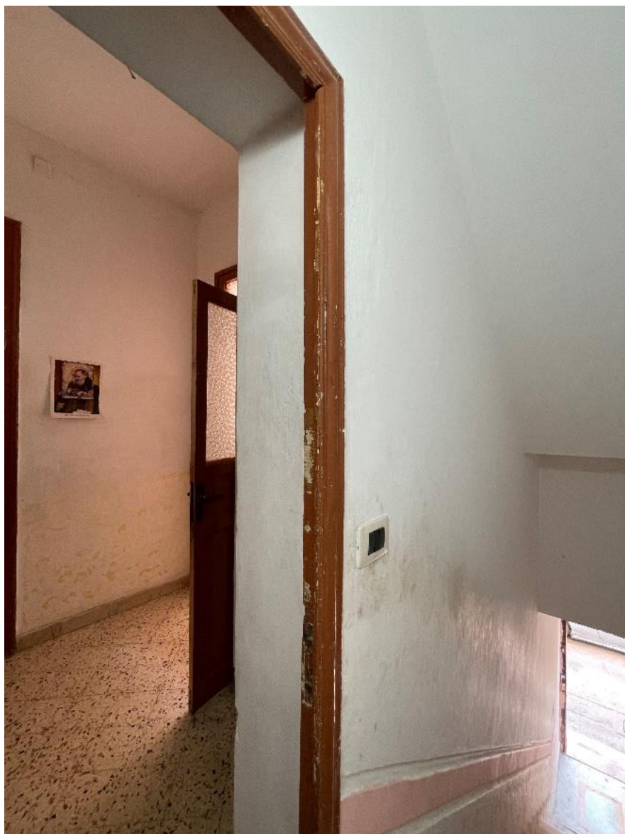
1° Piano - Ingresso appartamento
