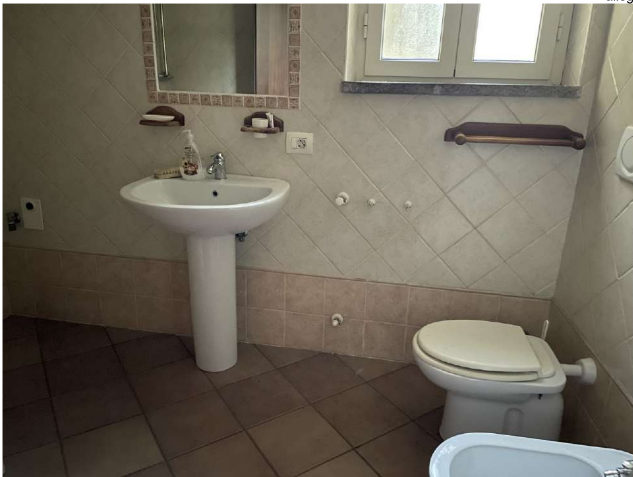
Dettaglio servizio igienico traslato in posizione
