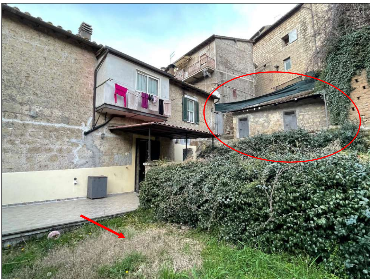
Vista complementare dell'area pertinenziale part.813 e dell'attiguo magazzino part.758
