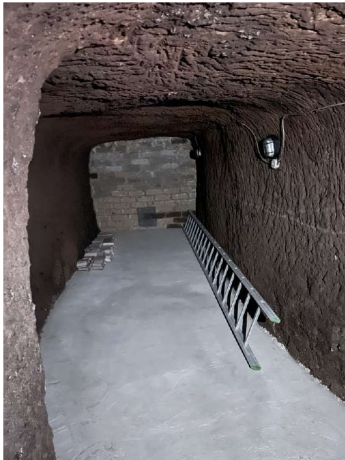
Dettaglio locale interrato contiguo scavato nel tufo
