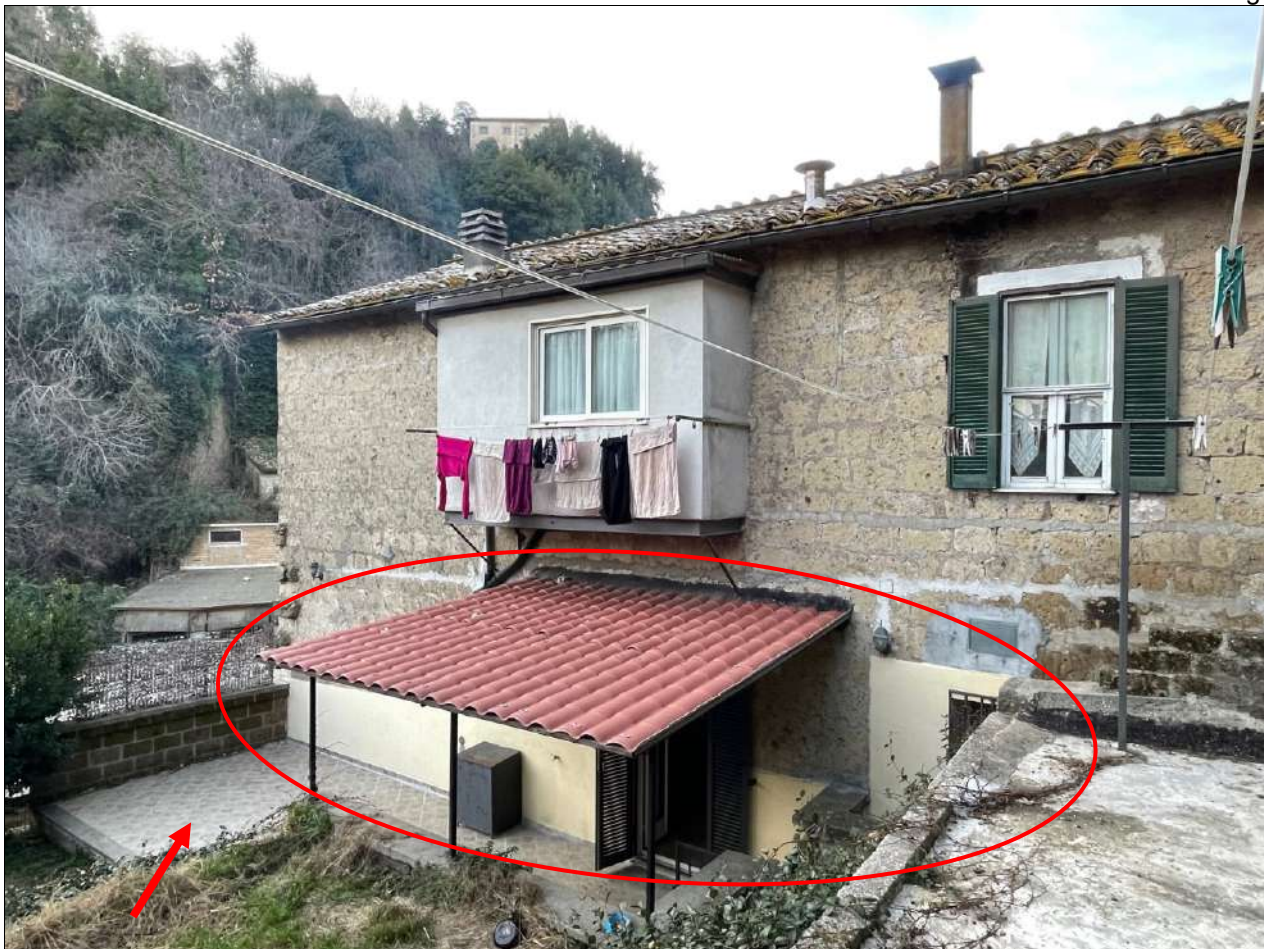
Vista del prospetto interno dell'immobile part.616 sub 7 e dell'area part.813
