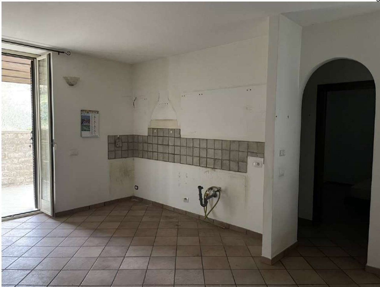
Dettaglio zona ingresso con angolo cottura abitazione part.616 sub 7
