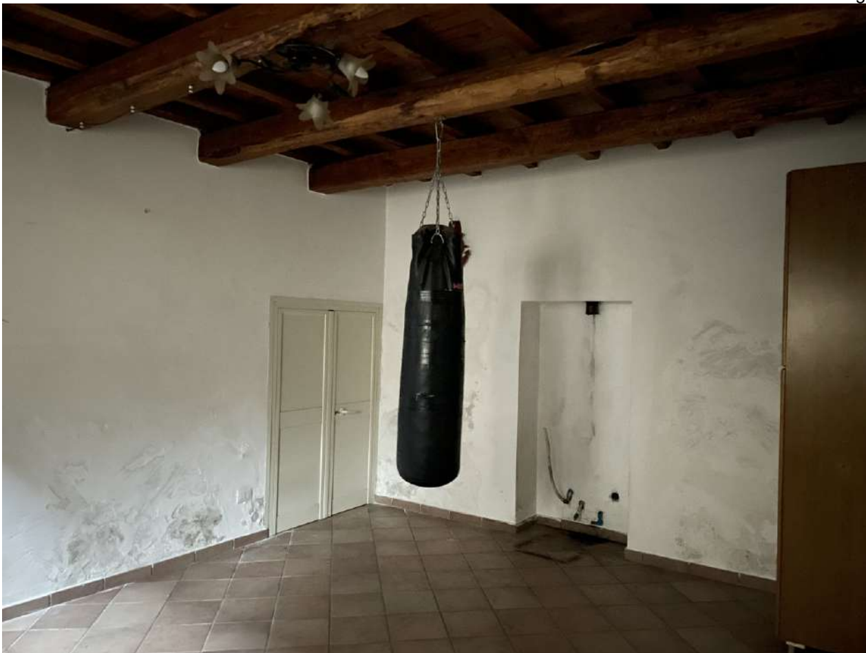
Dettaglio ambiente ex cantina riqualificata part.616 sub 4
