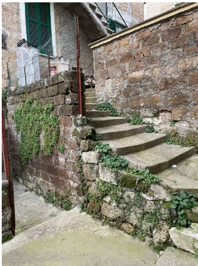
Vista complementare dell'area urbana in proprietà part.614
