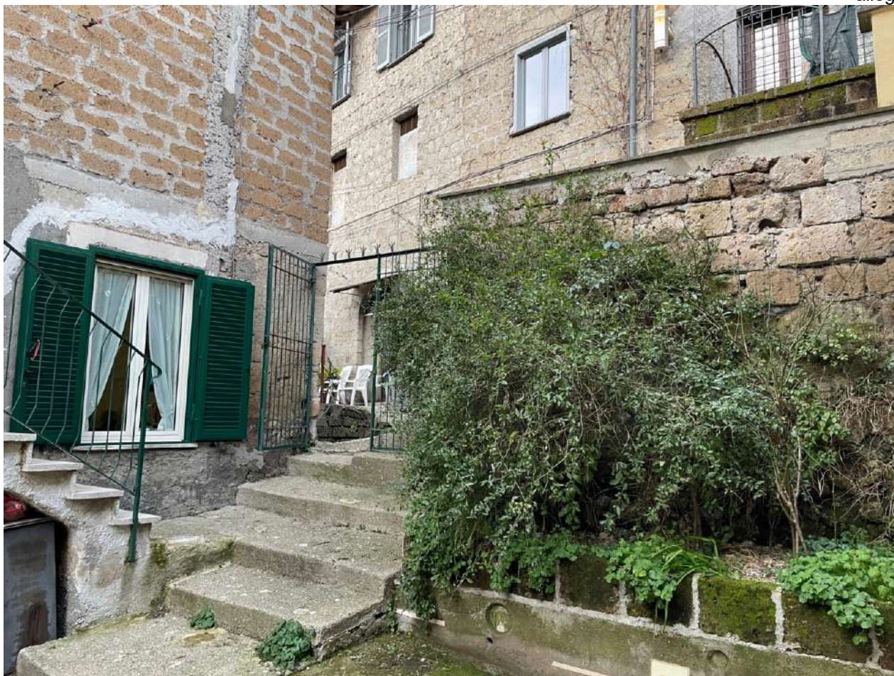
Vista dell'area di accesso comune part.614
