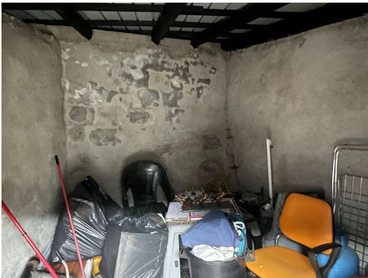
Dettaglio uno dei due locali del magazzino ex pollaio part.758
