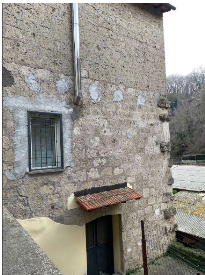
Vista del prospetto esterno dell'immobile cantina part.616 sub 4
