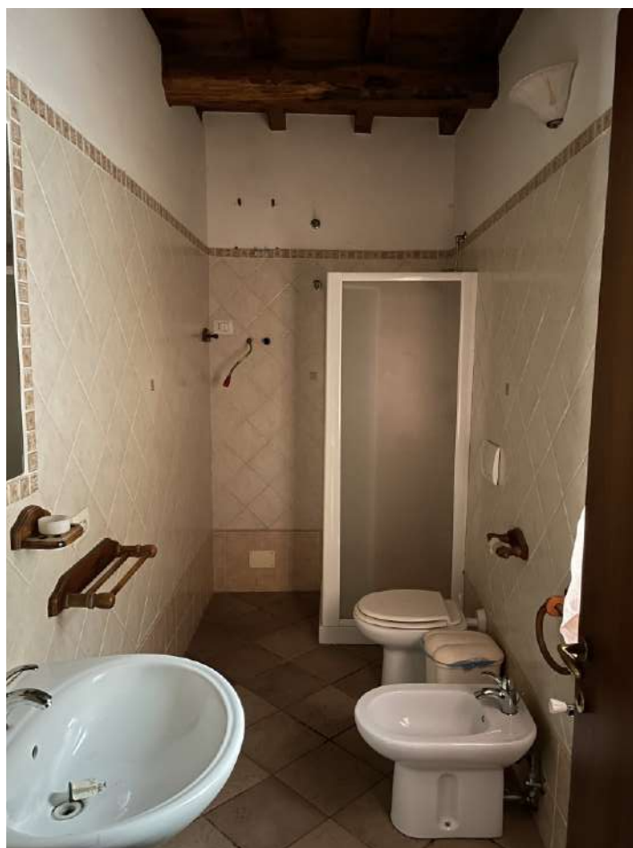
Dettaglio nuovo servizio igienico realizzato
