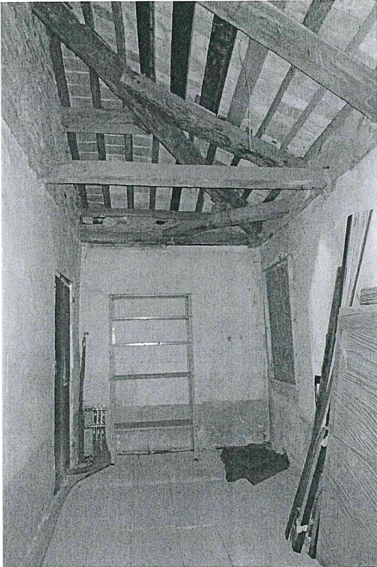
Foto 25 - Ripostiglio al primo piano
