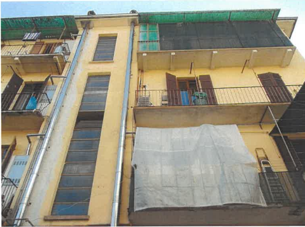
Foto 5 Prospetto fabbricato da cortile interno
