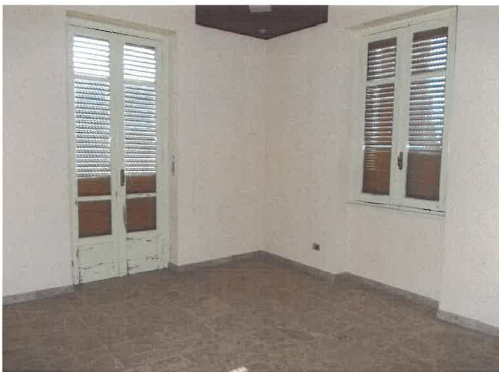
Foto 16 Camera alloggio sub.7
