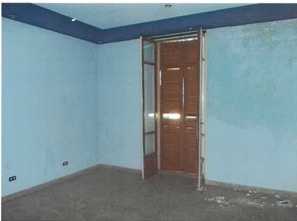
Foto 14 Camera con finestra chiusa alloggio sub.7
