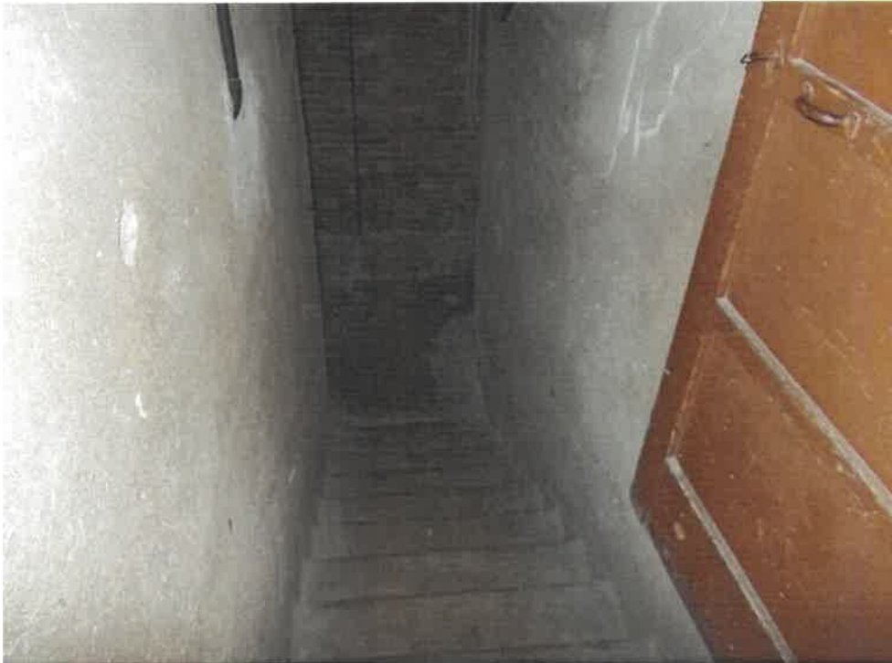
Foto 17 Scala accesso piano cantine S1
