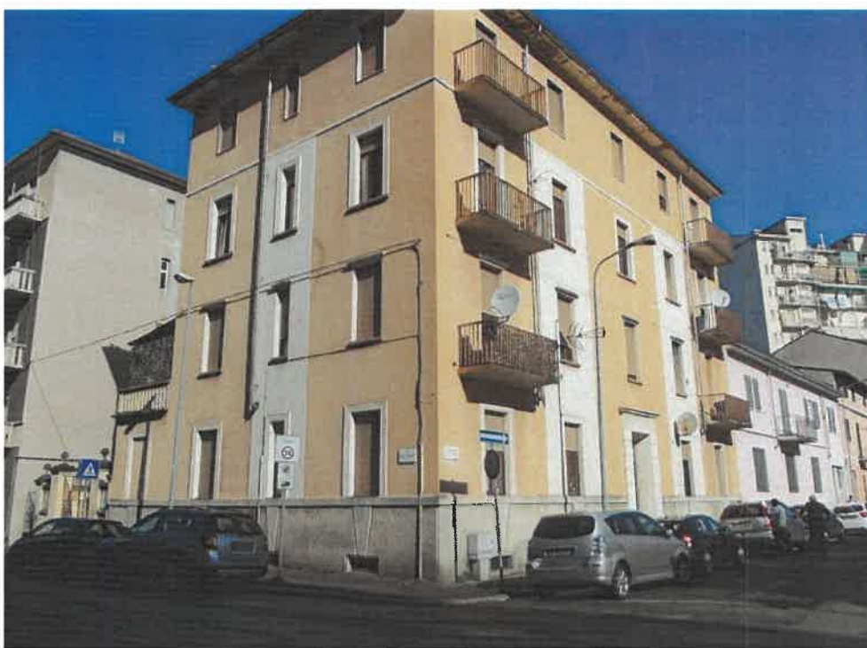
Foto 2 Prospetto fabbricato da Via D'Angennes-Via Maggioli
