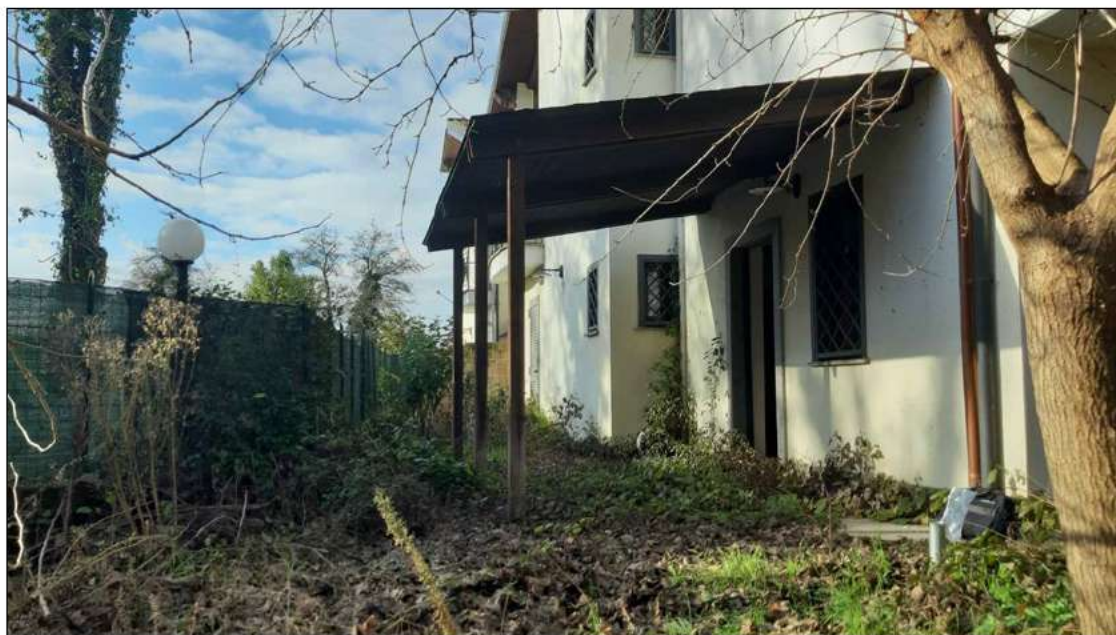
foto 7 - vista della tettoia in legno posta nel giardino.
