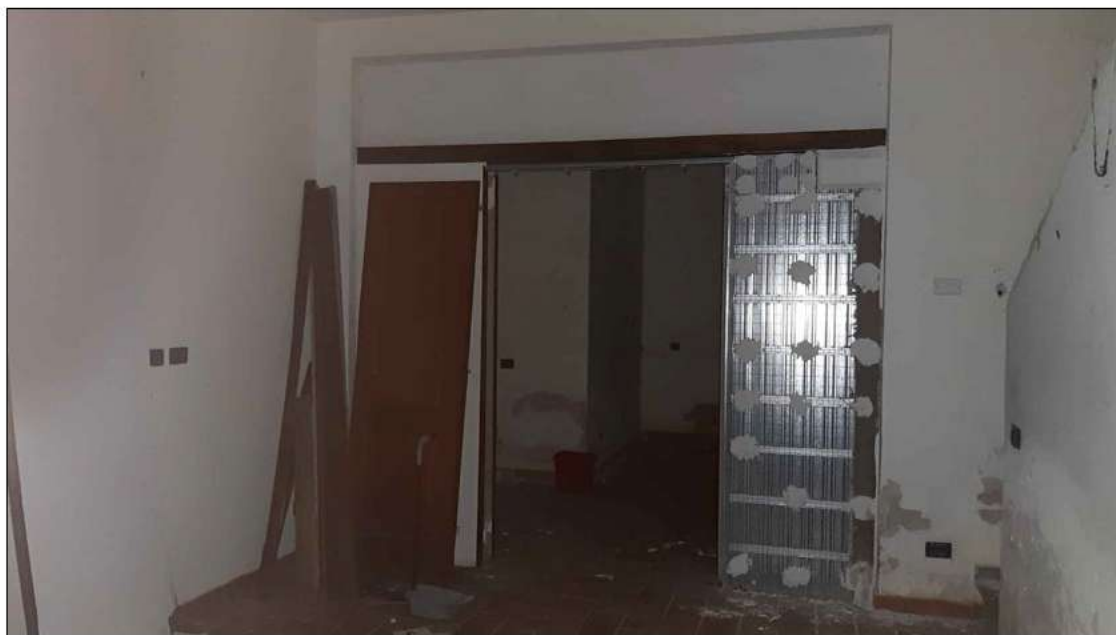
foto 15 - vista interna del locale posto nel piano seminterrato.
