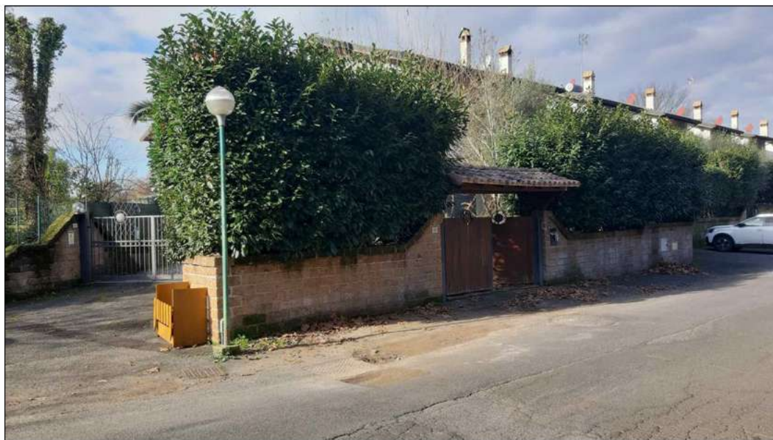
foto 1 - vista esterna dell'ingresso da Viale Giuseppe Verdi.
