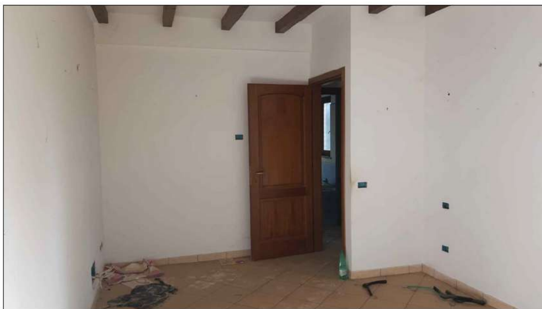
foto 24 - vista interna della camera n.2 posta al piano primo.
