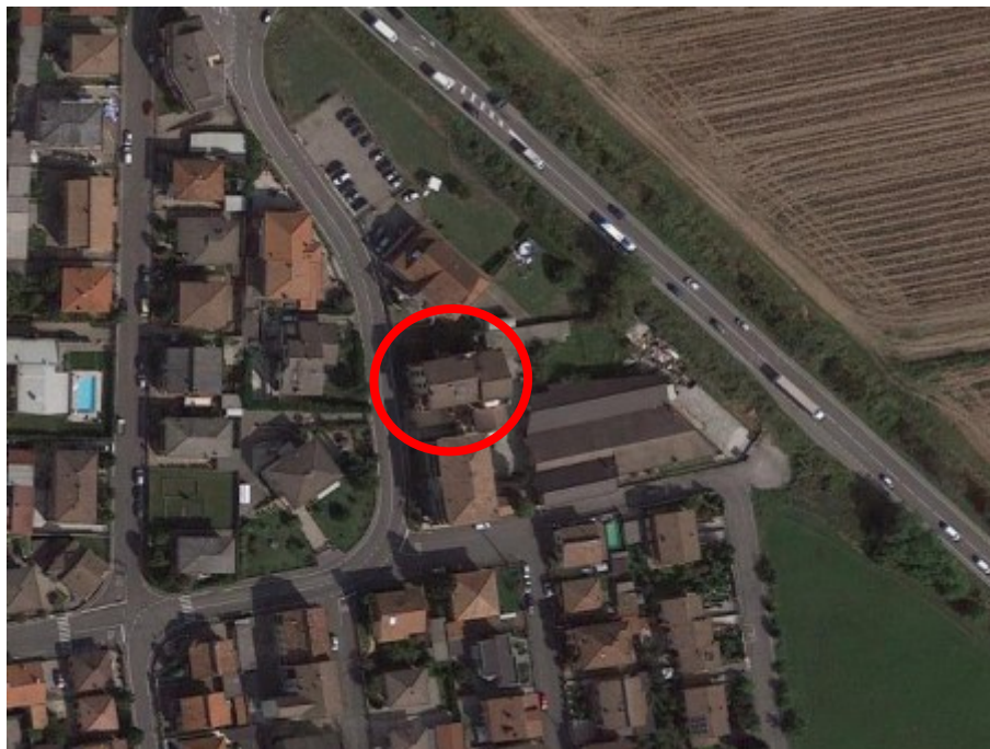
FOTO 2 – particolare vista dall'alto
