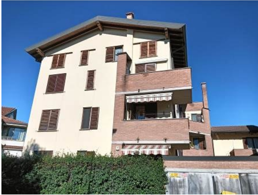
FOTO 3 – vista da via Ada Negri
