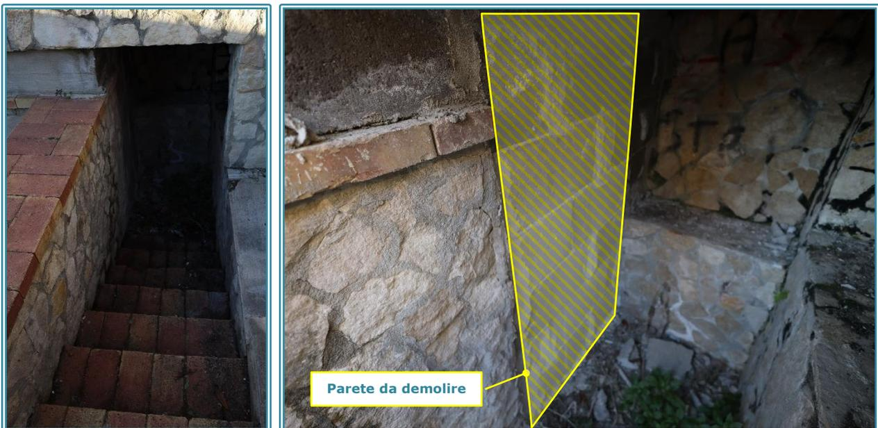
Figura 6 Accesso al piano interrato con evidenziazione della parete da demolire
