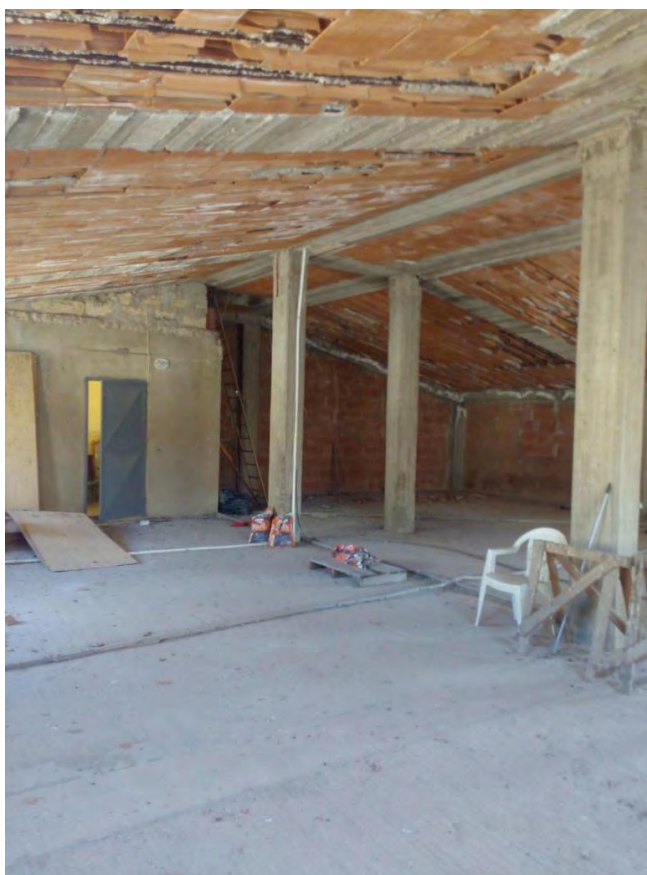
Foto 32 – Vista piano secondo - grezzo
