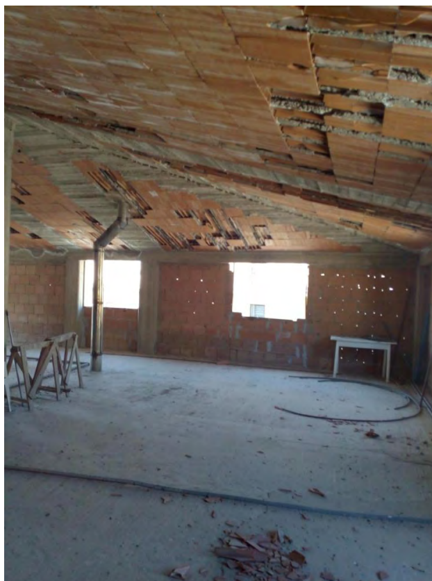
Foto 31 – Vista piano secondo - grezzo
