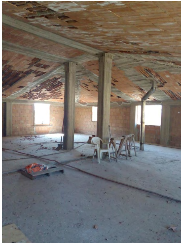
Foto 30 – Vista piano secondo - grezzo
