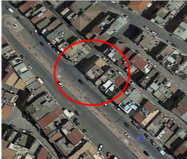
Fig.2. Posiz. 1 -ubicazione immobile sulla via Mario Gori
