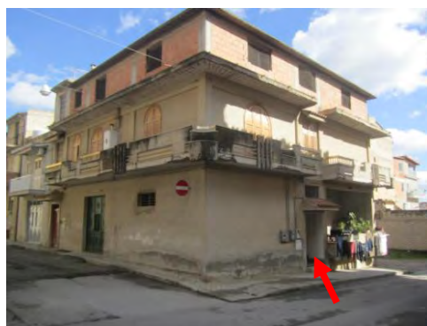
Angolo via Caravaggio e via F.lli Rosselli- Ingresso del piano terra
