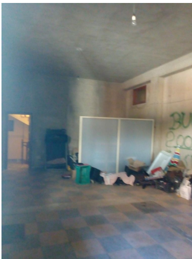
Foto 16 – Garage a piano terra
