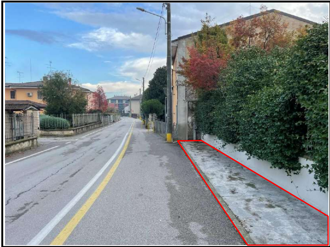
Foto 17 Bene 10 – Viabilità – Strada Pedagno
