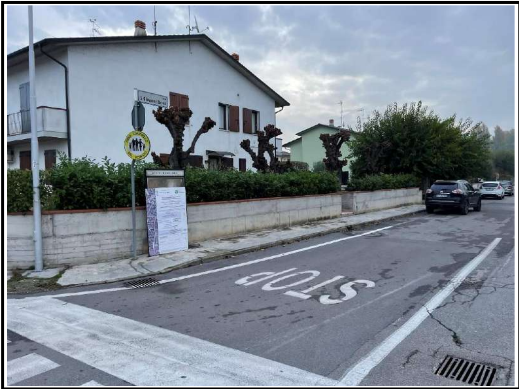
Foto 19 Bene 10 – Viabilità – Via San Giovanni Bosco
