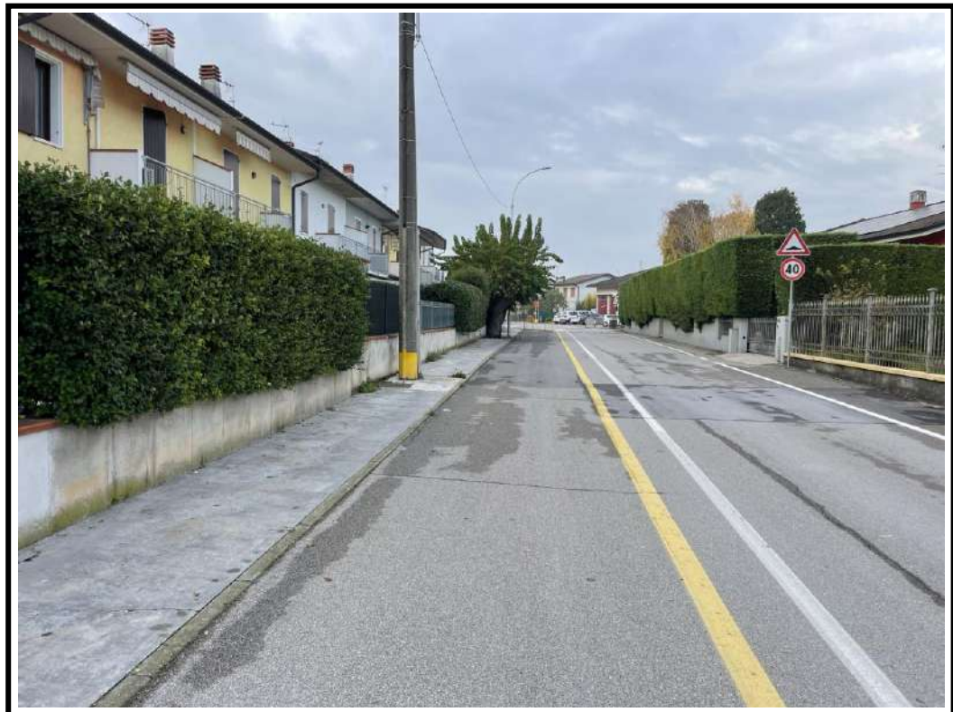
Foto 18 Bene 10 – Viabilità – Strada Pedagno
