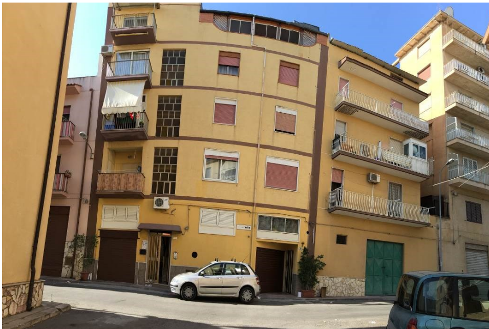
Foto 1- Prospetto sulla via Nilo
