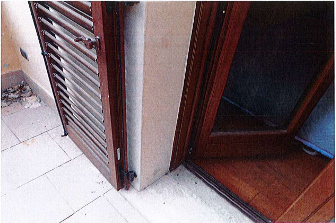
Particolare infisso interno
