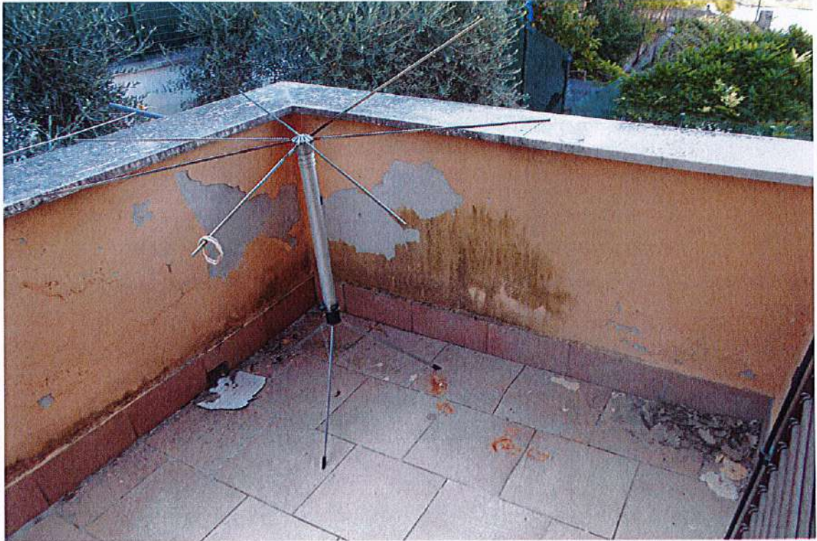
Particolare balcone camera
