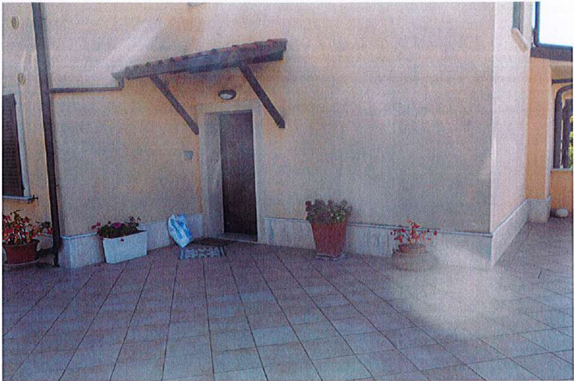
Portoncino di ingresso edificio
