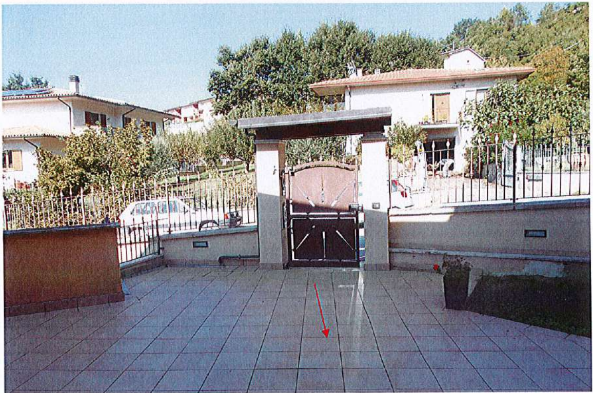
Ingresso all'edificio dal cancello pedonale
