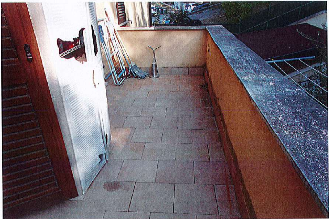
Particolare balcone camera
