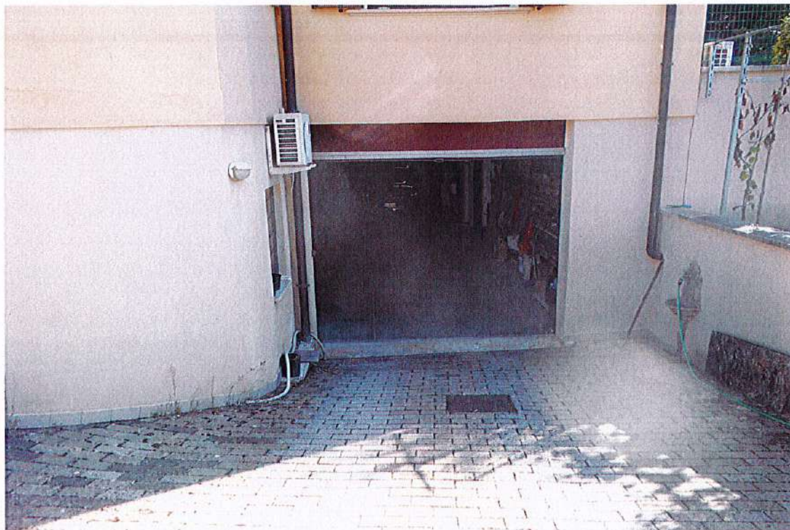
Ingresso carrabile dalla corte comune
