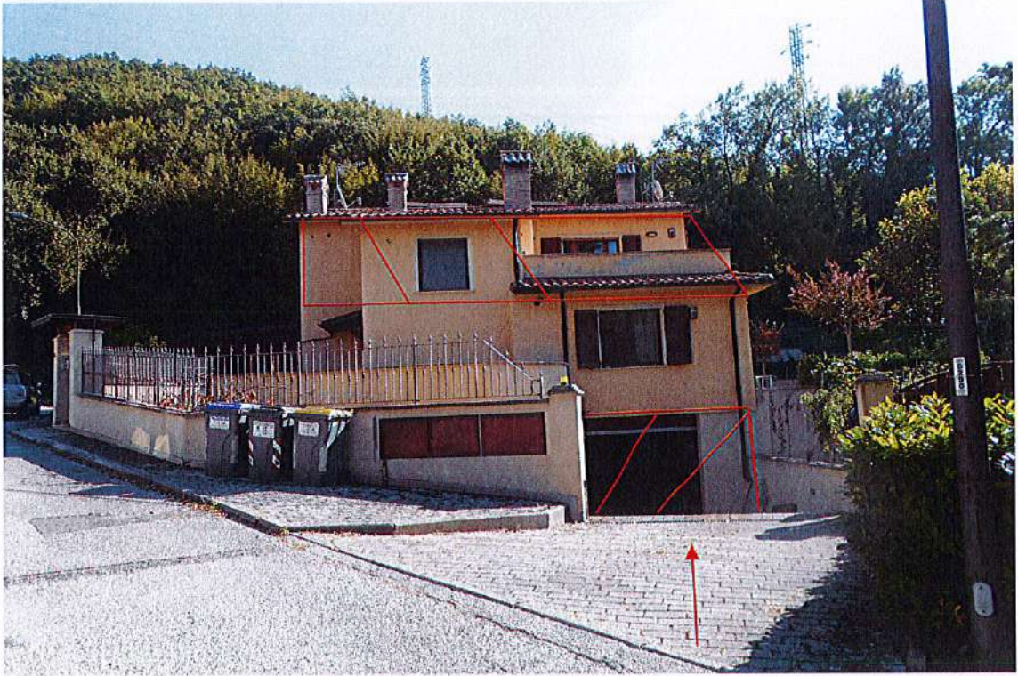
Vista fabbricato lato retro
