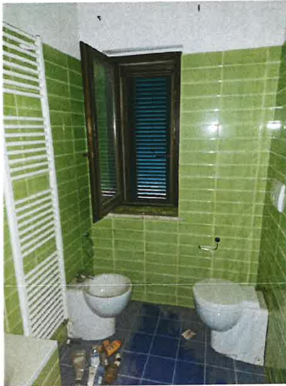
Foto 11 - Piano secondo, bagno
