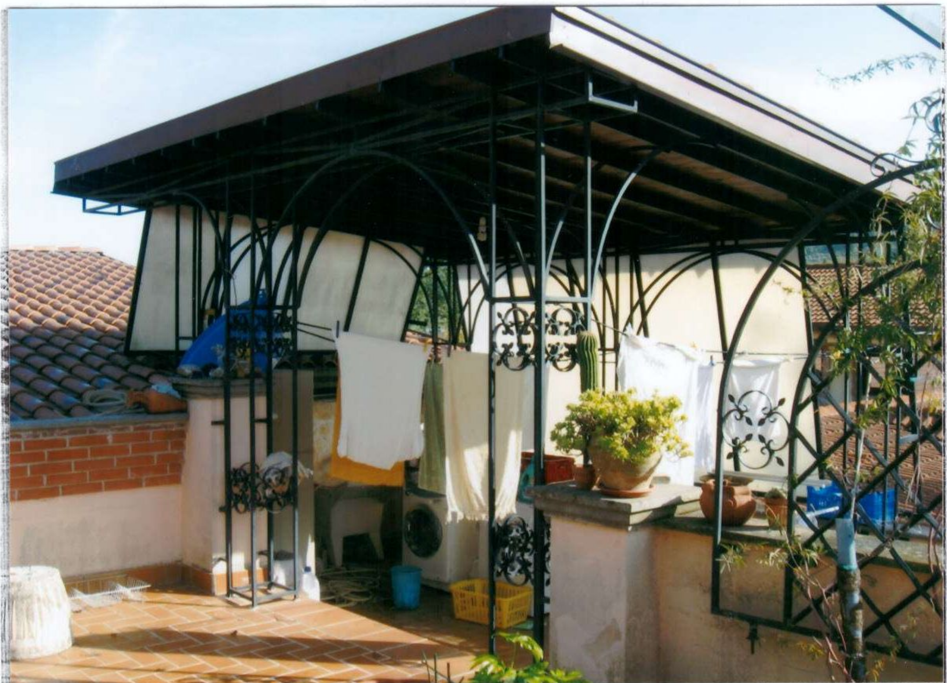
VISTA DI UNA TERRE IN FERRO POSIZIONE
