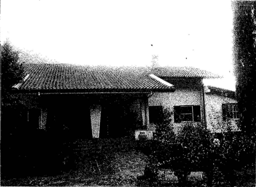
PORZIONE DI FABBRICATO OGGETTO DI PROCEDIMENTO LATO DESTAG
