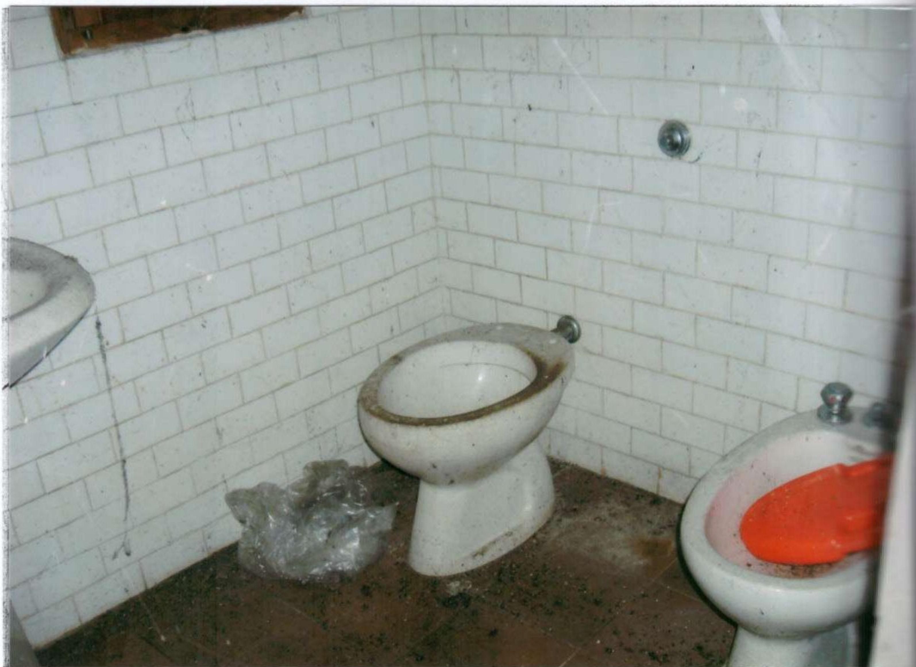
VISTA DEL BAGNO INTERNO ALLA DEPANDANCE
