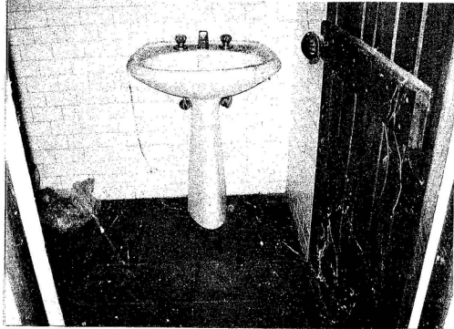
VISTA DEL BAGNO INTERNO ALLA DEPANDANCE
