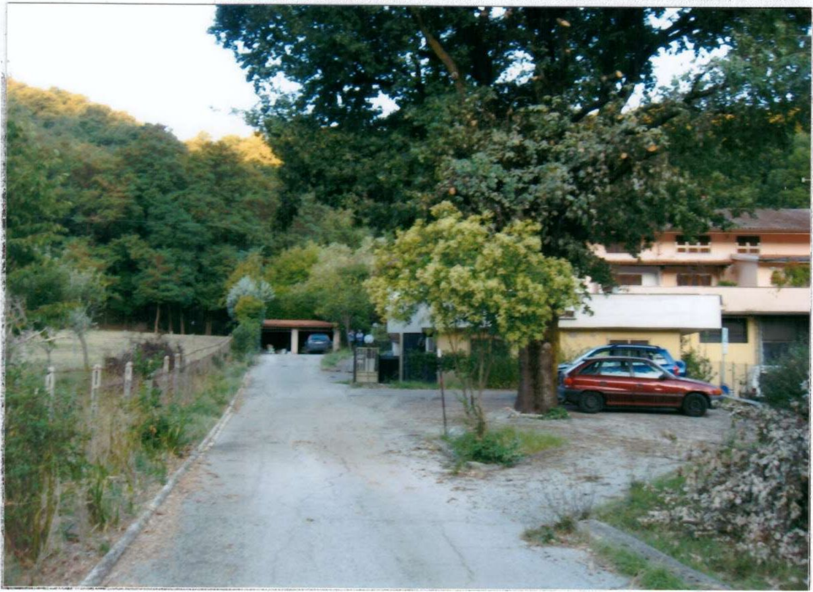
LOCALI GARAGE - A SINISTRA VISTA DEL VIALE DI ACCESSO CON IN FONDO IL
