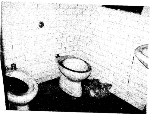
VISTA DEL BAGNO INTERNO ALLA DEPANDANCE
