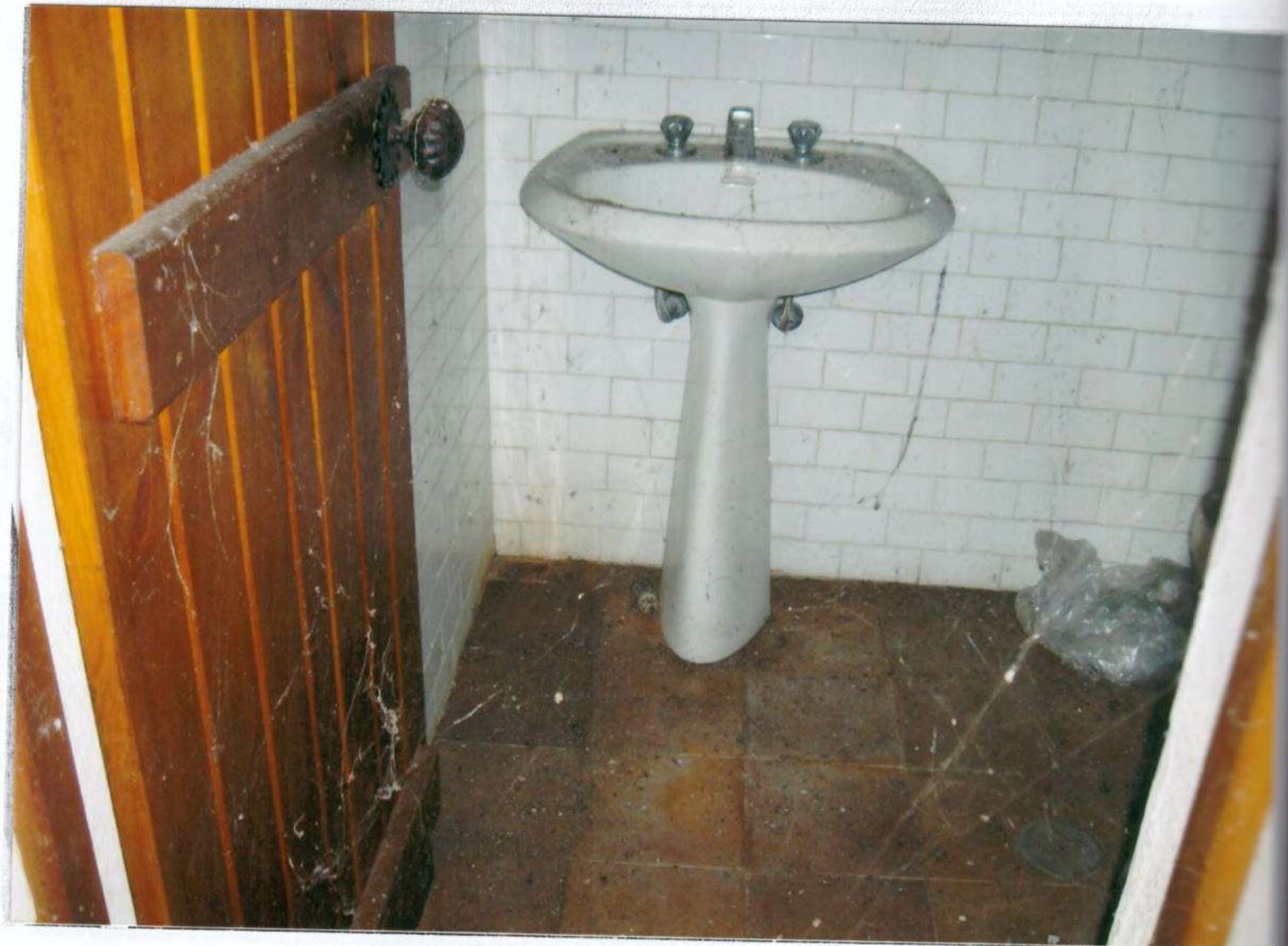
DEPANDANCE VISTA DEL BAGNO INTERNO ALLA
