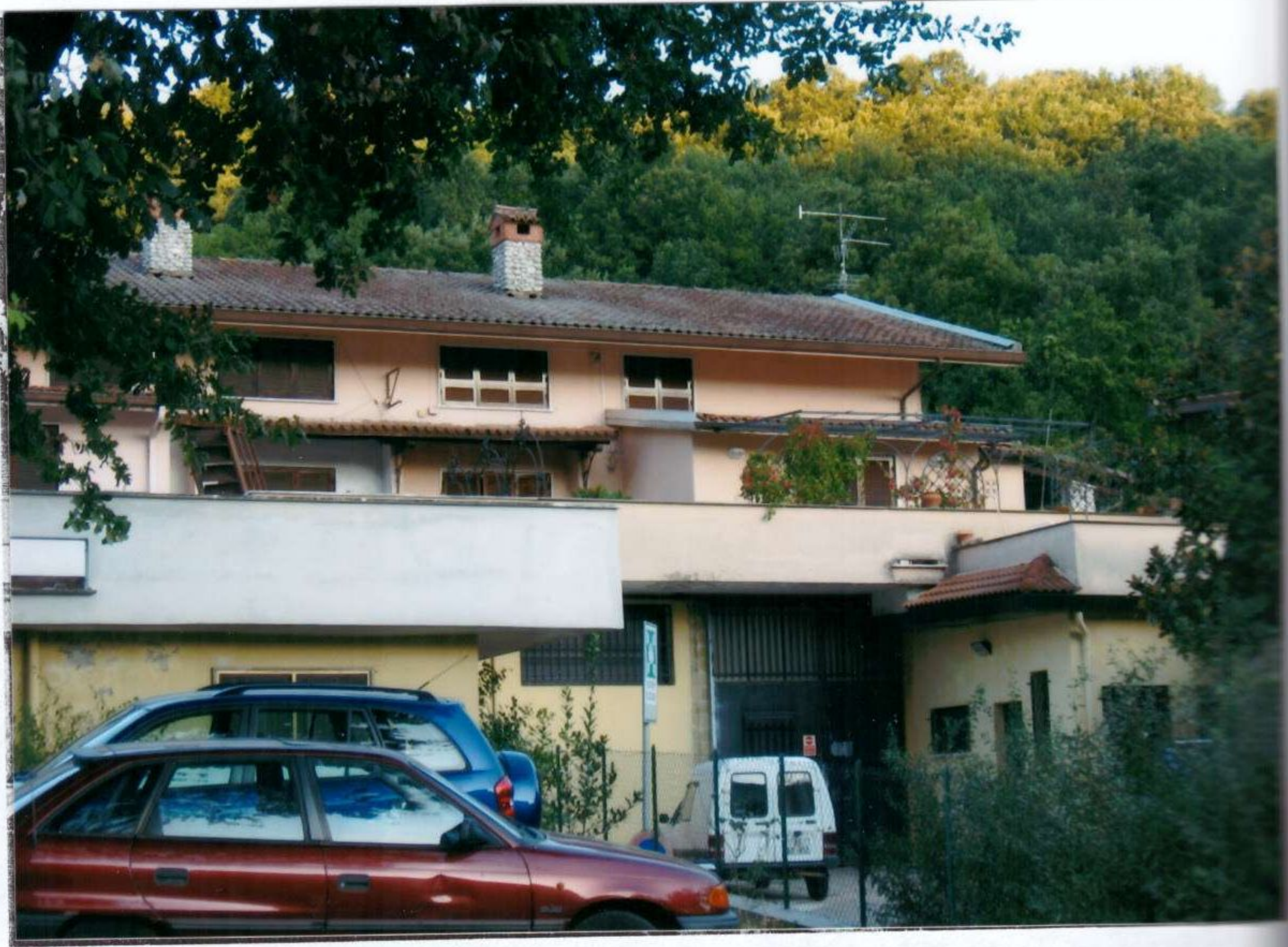
OGGETTO DI PROVVEDIMENTO IN ASIA A SINISTRA. VISTA DEL FABBRICATO - POSIZIONE
