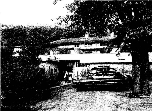
VISTA TOTALE DEL FABBRICATO
