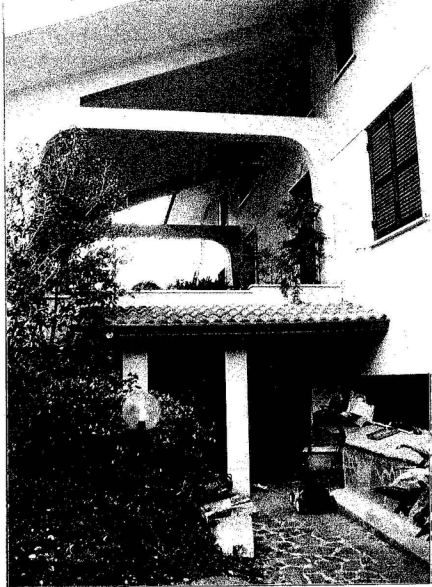
VISTA DEL MAGAZZINO E DEL PORTICO CHE DA ACCESSO AL FABBRICATO
