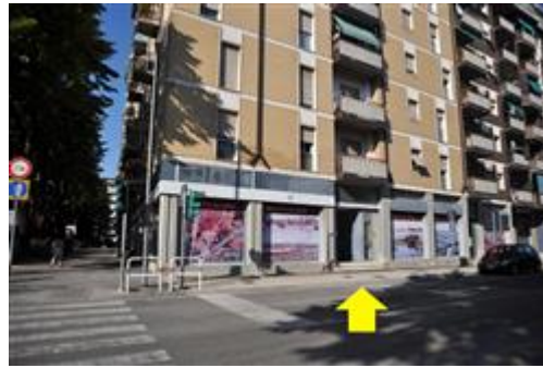
Vista dell'ingresso da Via G. Carducci
