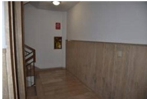
Vano scale condominiale
