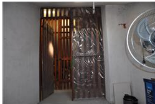
Soffitta di proprietà vista dall'interno
