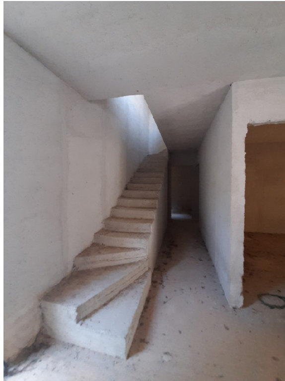
Foto 7 – Scala di accesso al piano primo sub3
