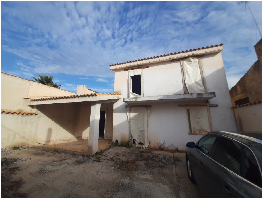
Foto 1- Vista d'insieme del fabbricato oggetto di stima Sub3
