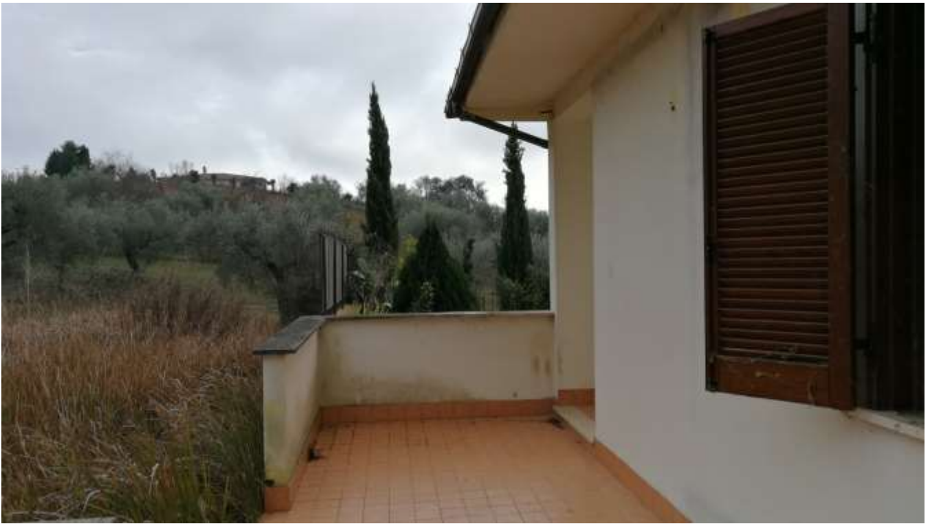
FOTO 07 – LASTRICO SOLARE (Sub. 536)
