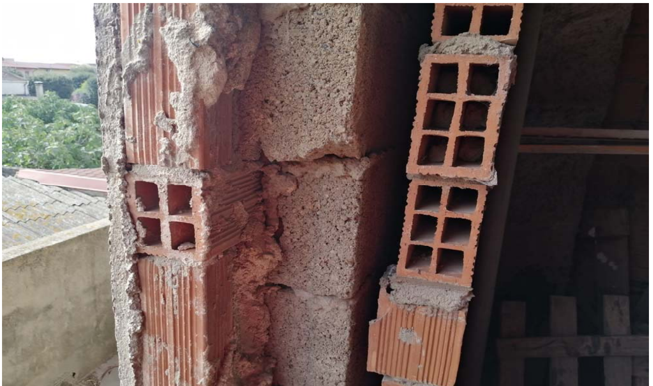
Foto 24: Particolare sulla muratura esterna dell'immobile in corso di costruzione (sub. 7).
