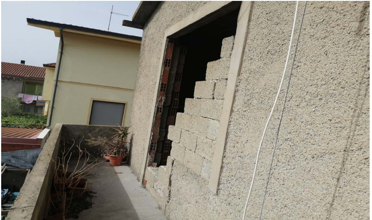
Foto 25: Vista della balconata dell'immobile in corso di costruzione (sub. 7).
