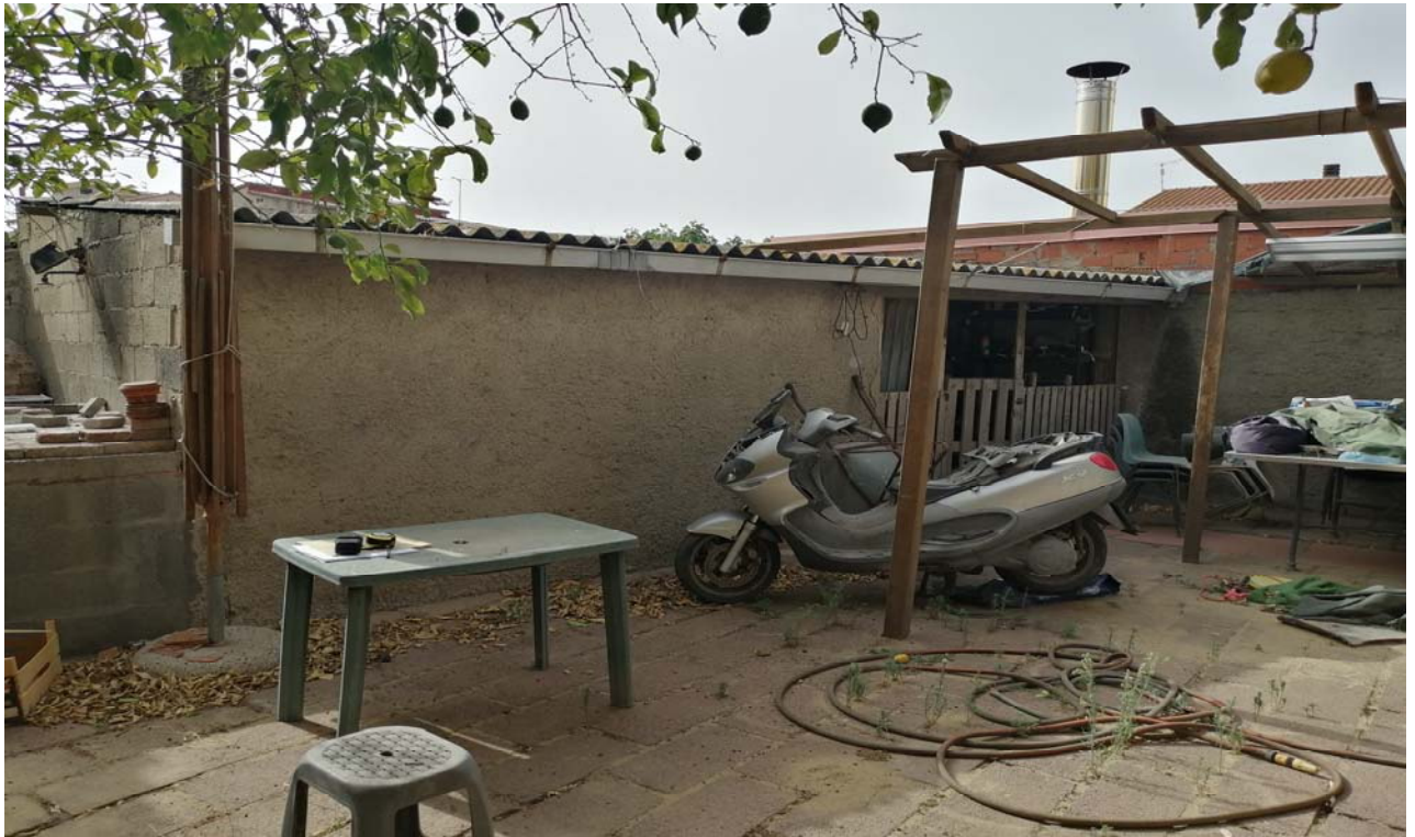
Foto 15: Vista dell'immobile a destinazione locale di sgombero / deposito (sub. 5).
