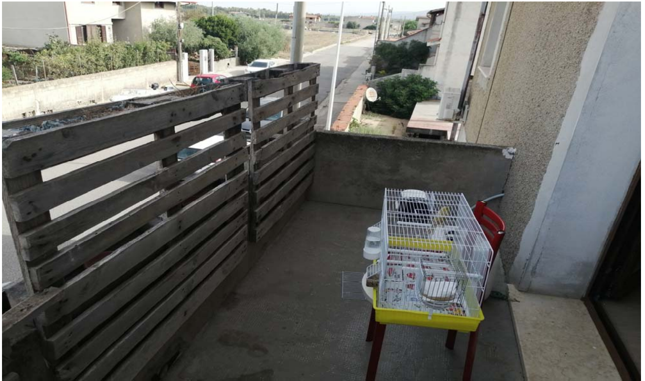
Foto 13: Particolare del balcone (sub. 6).
