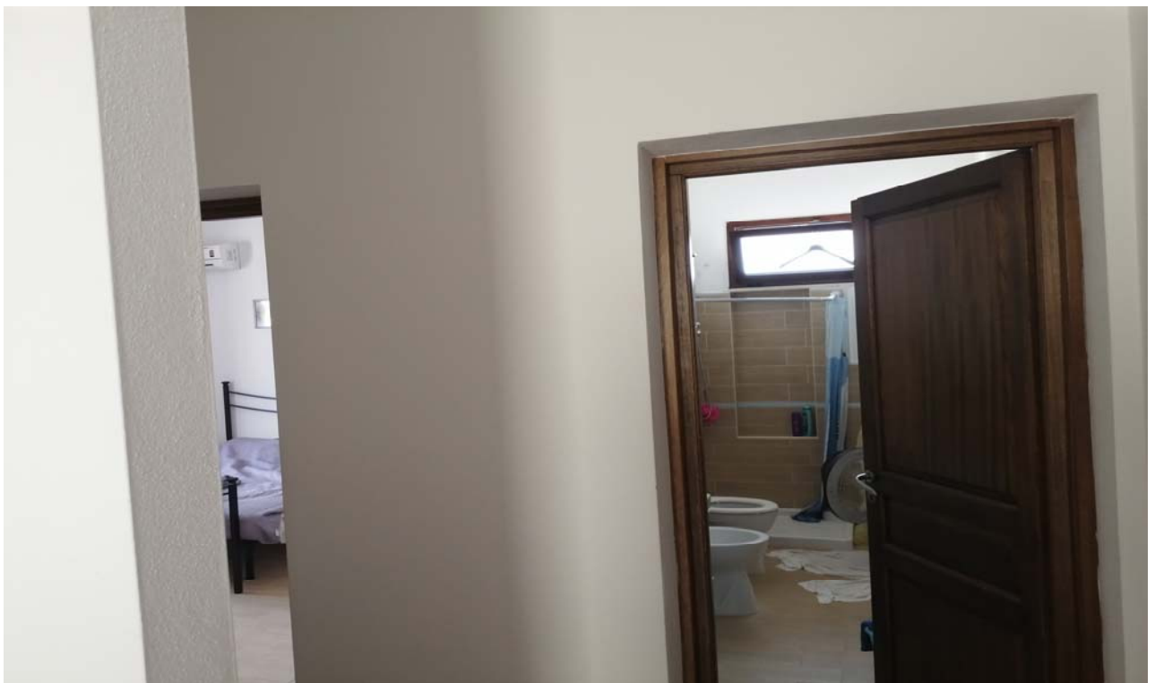
Foto 6: Particolare sul corridoio (sub 6).
