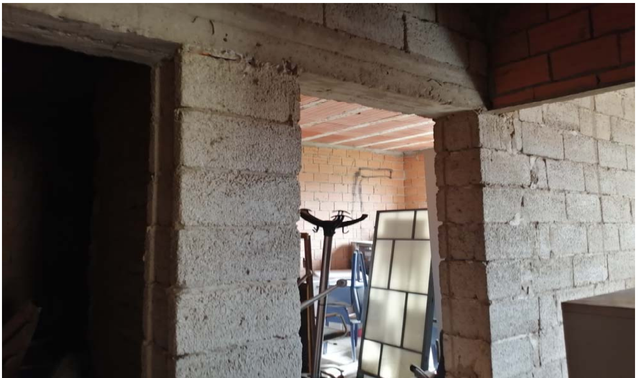
Foto 22: Altra vista interna dell'immobile in corso di costruzione (sub. 7).
