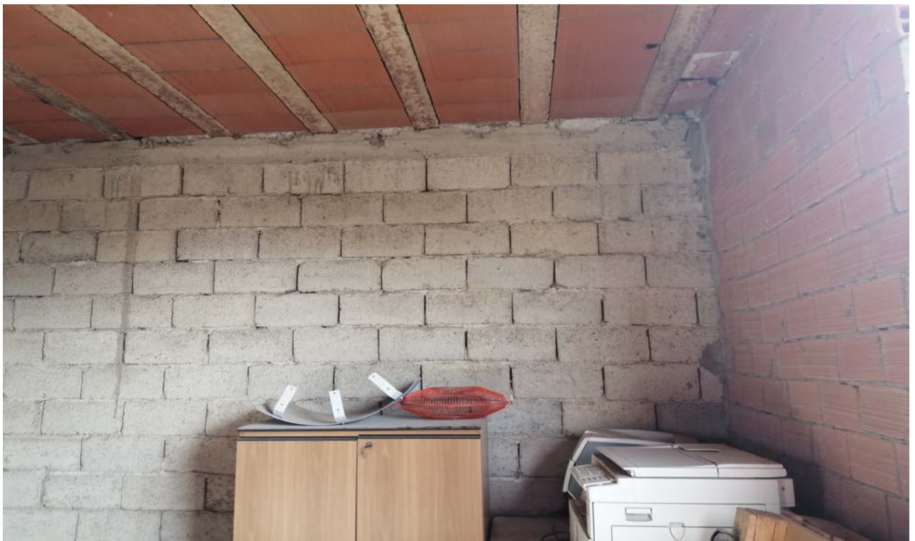
Foto 20: Altra vista interna dell'immobile in corso di costruzione (sub. 7).
