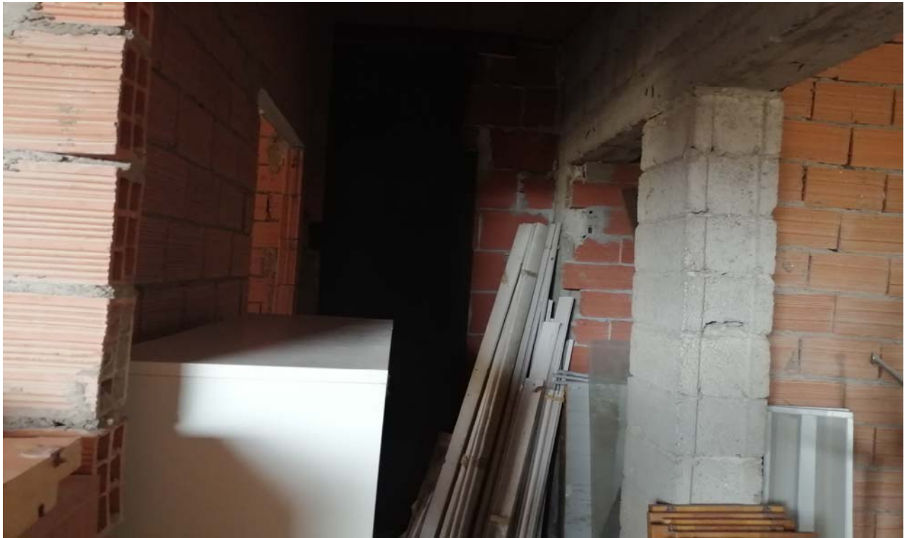
Foto 21: Altra Vista interna dell'immobile in corso di costruzione (sub. 7).
