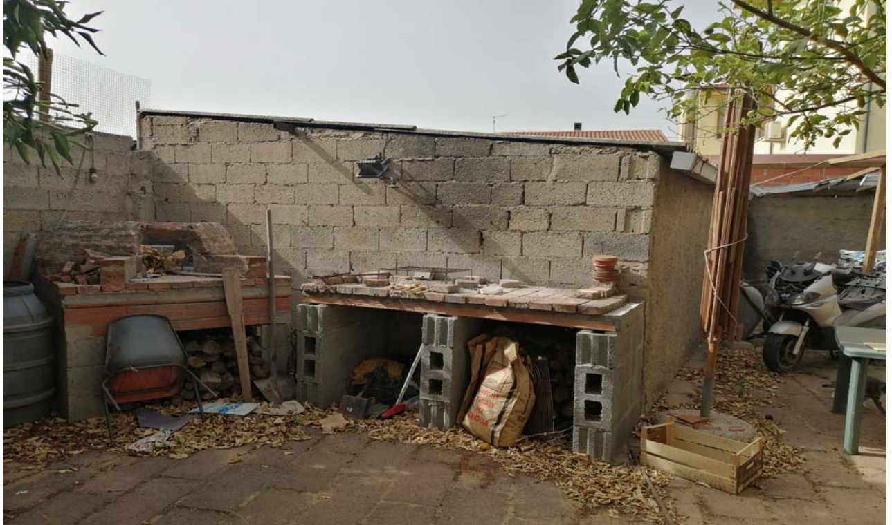
Foto 17: Particolare sull'immobile a destinazione locale di sgombero / deposito (sub. 5).
