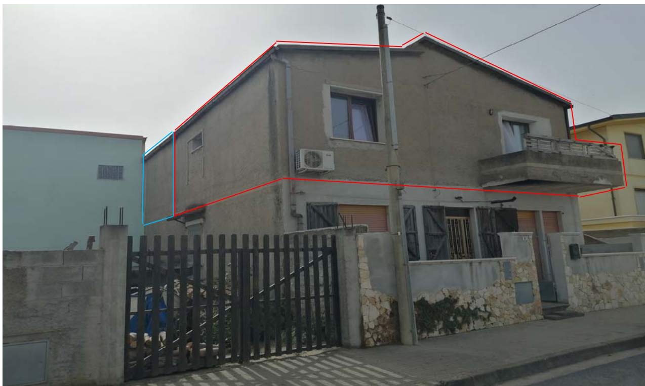
Foto 2: Altra vista d'insieme degli immobili oggetto della perizia. Al piano primo le 2 unità immobiliari in interesse; rosso sub 6 (unità residenziale) – celeste sub 7 (unità in corso di costruzione).
