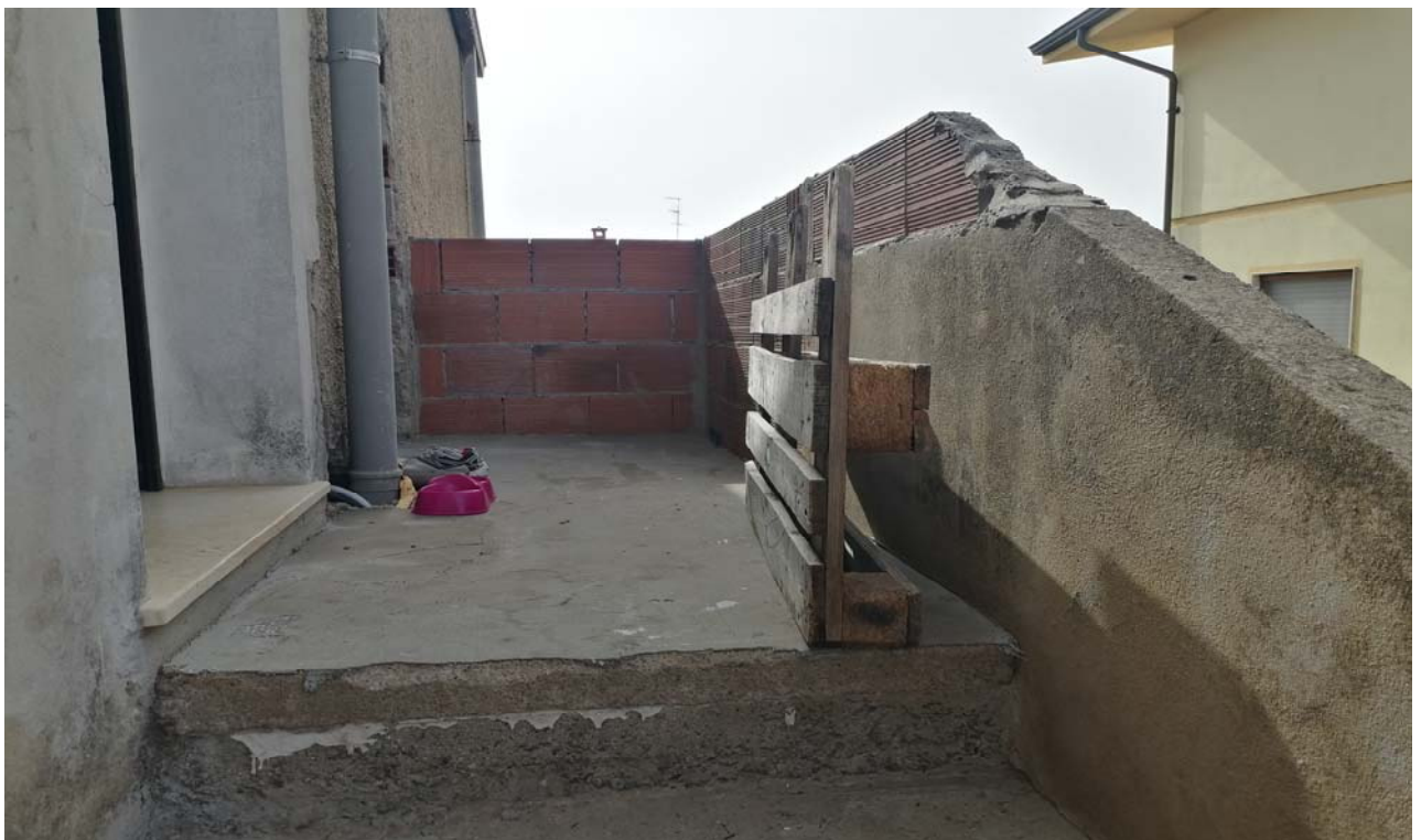
Foto 14: Vista sul disimpegno di accesso ai sub. 6 e 7 (sub. 8, BCNC).
