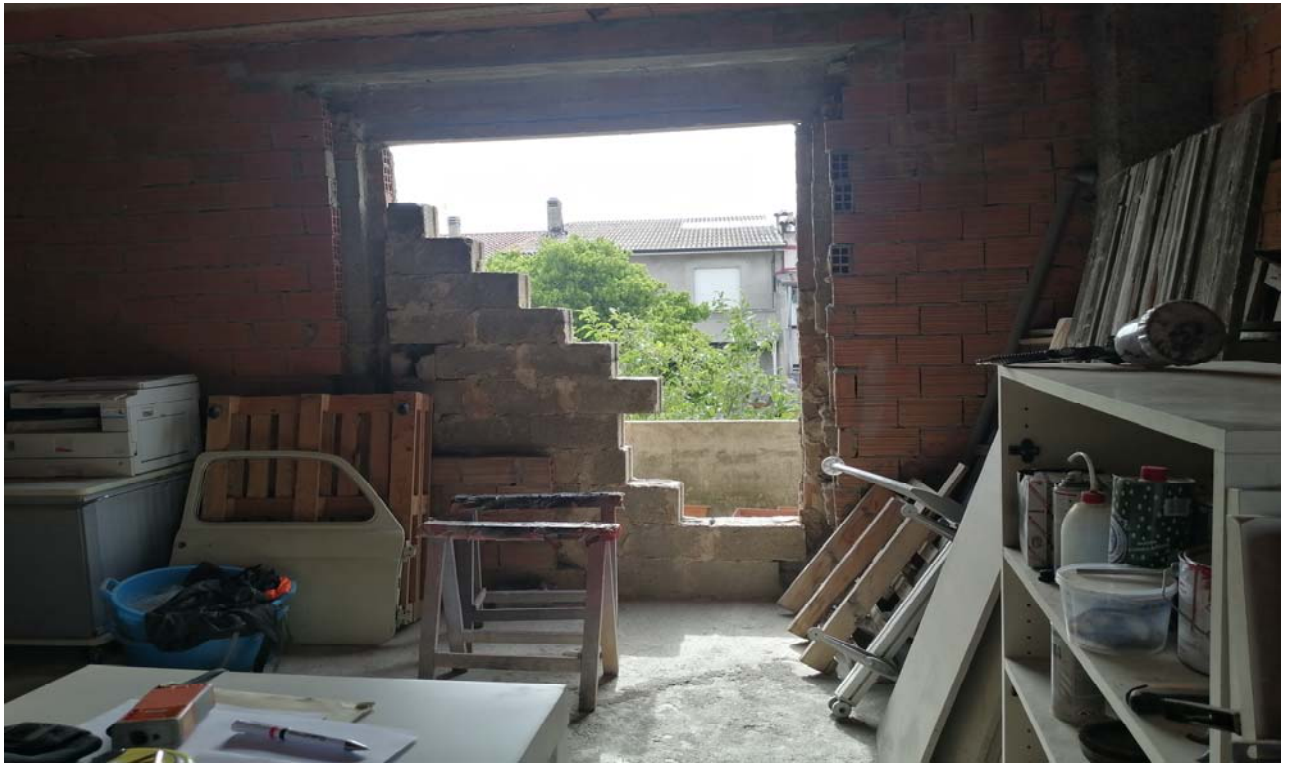
Foto 19: Vista interna dell'immobile in corso di costruzione (sub. 7).
