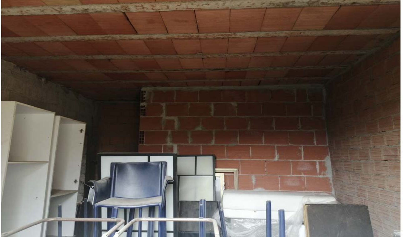
Foto 23: Altra vista interna dell'immobile in corso di costruzione (sub. 7)..
