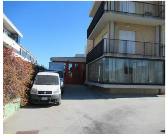
Foto 2 – Palazzina uffici ed opificio
