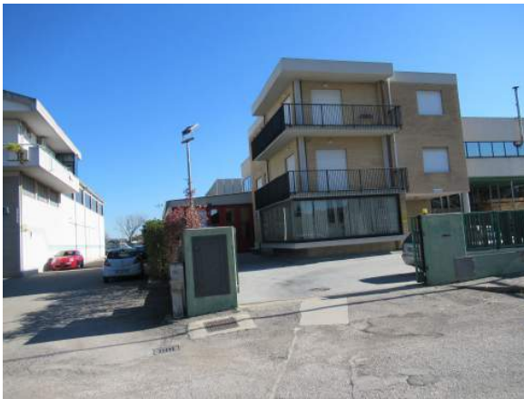
Foto 3 – Veduta complesso industriale- Ingresso
