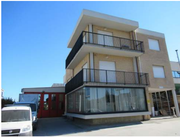
Foto 1 – Palazzina uffici ed opificio
