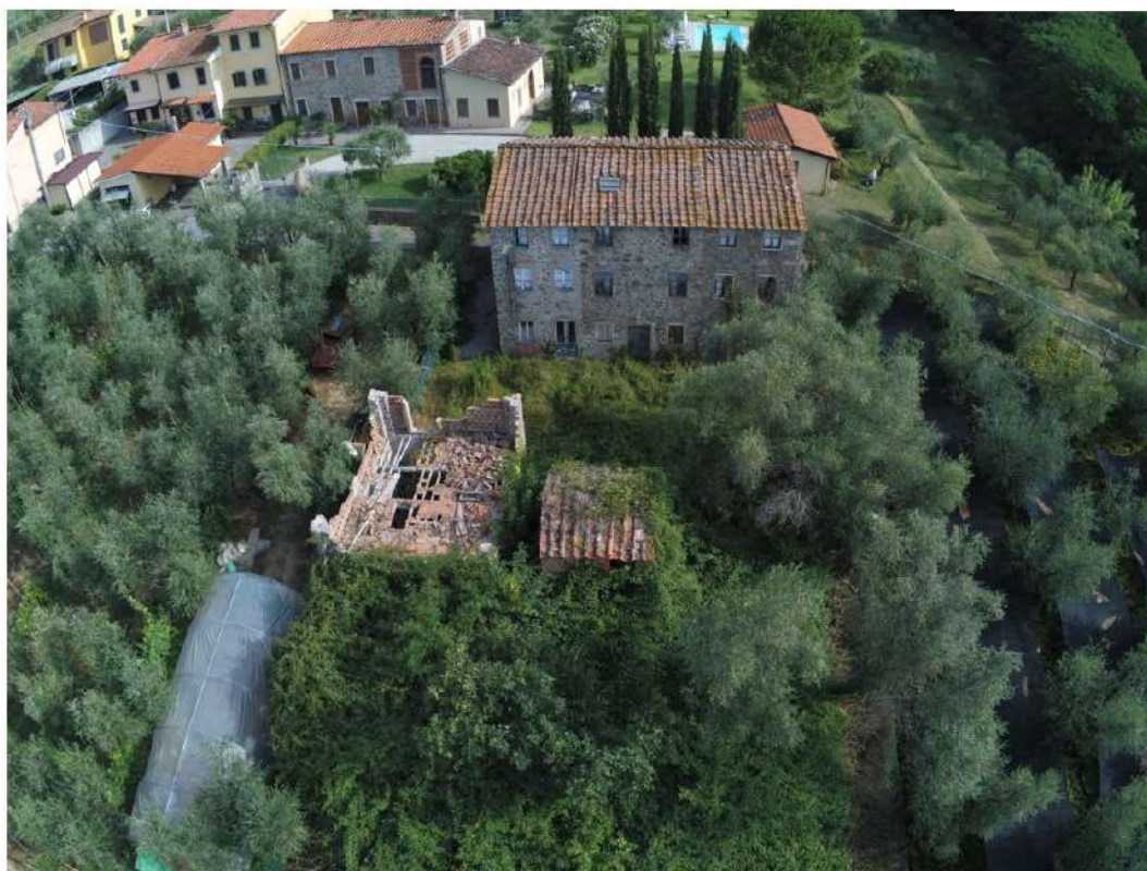
Fabbricato principale i fabbricati pertinenziali semidiruti e circostante terreno
