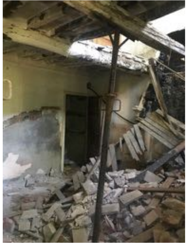
Foto 10-11 – Vista interni con solaio crollato
