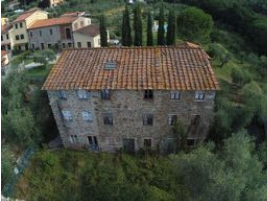
Foto 2 – Vista fronte sud
