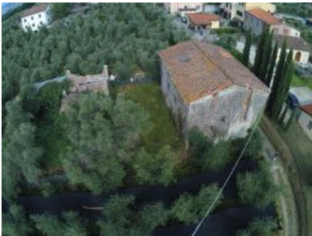
Foto 6 – Vista compendio lato est
