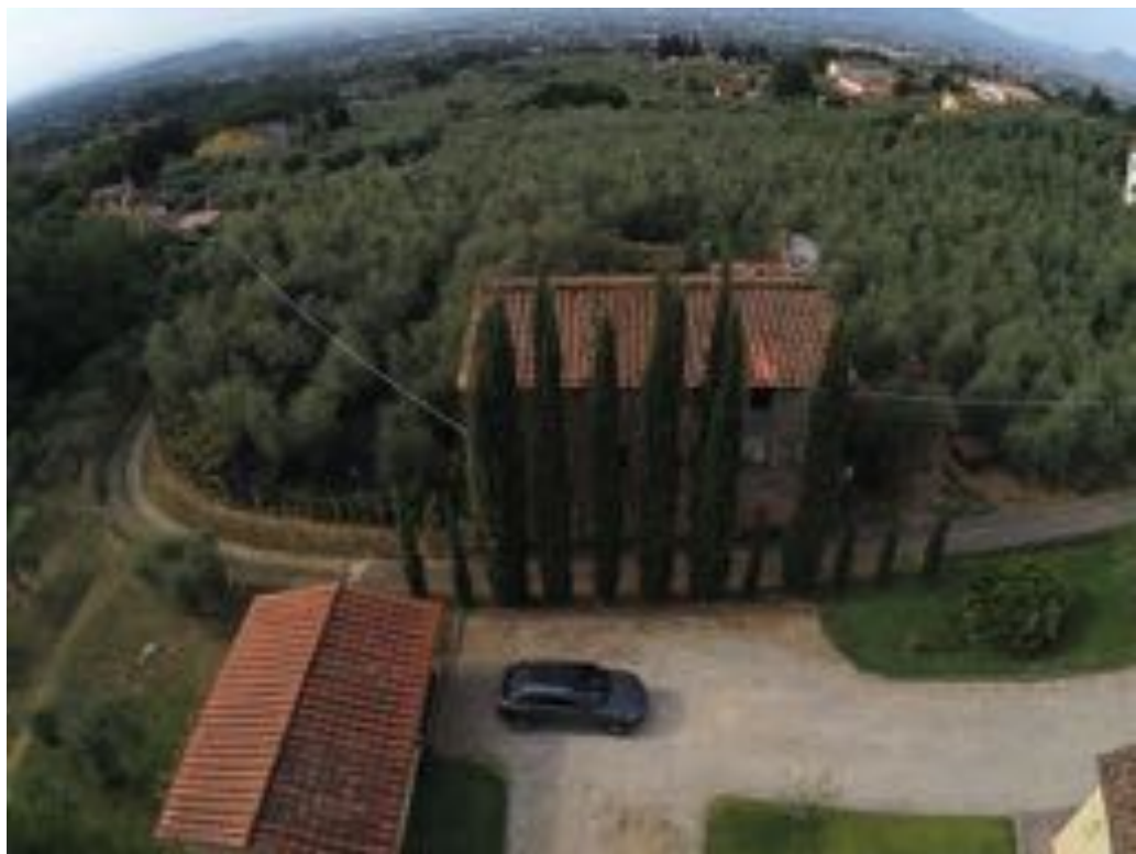
Foto 5 – Vista compendio lato nord
