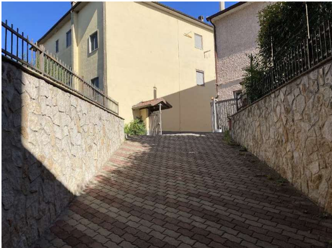
Foto 37 – rampa d'accesso a box/cantine
