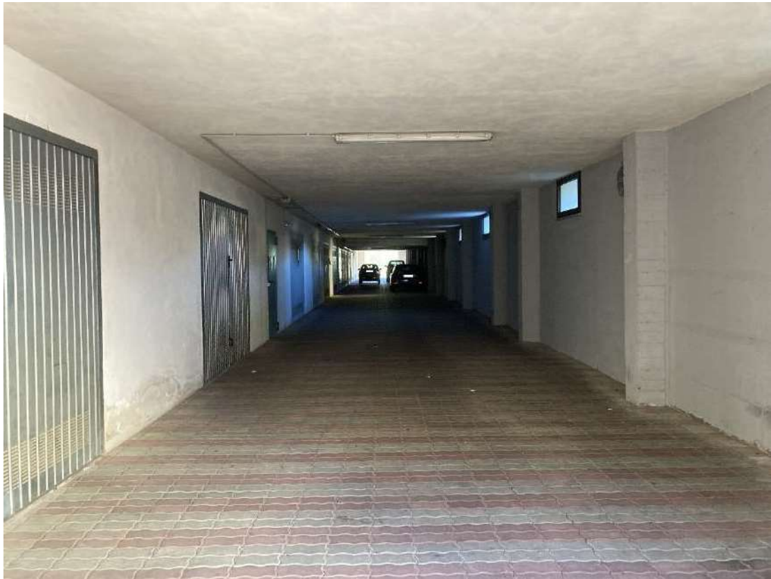
Foto 38 – area per accesso a box/cantine
