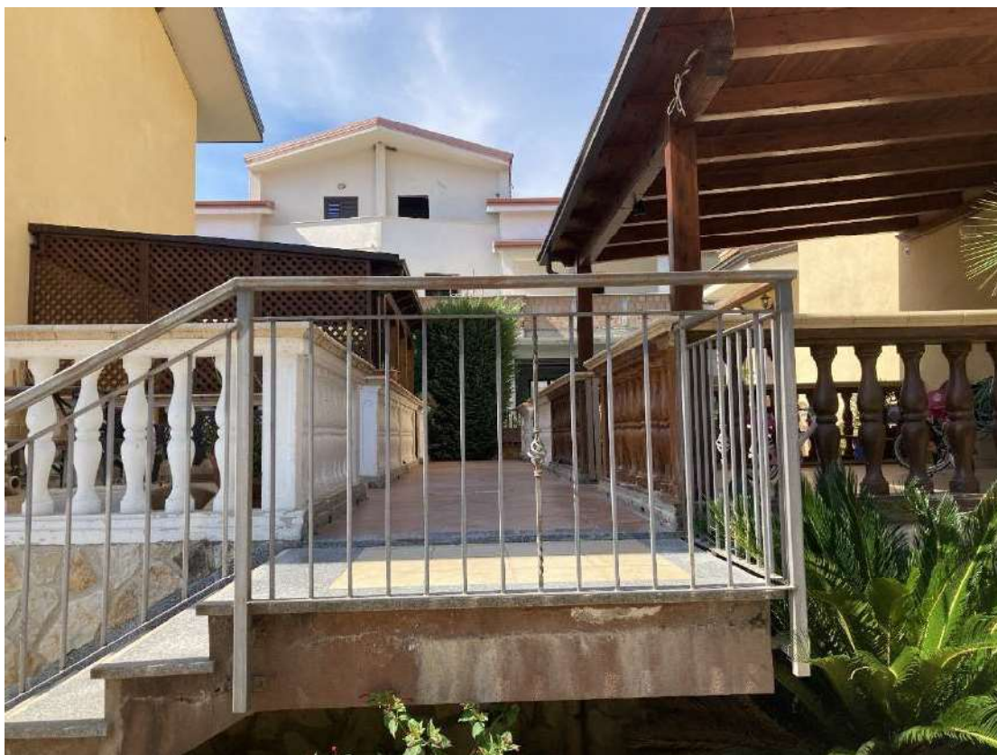
Foto 3 – scala esterna di accesso
