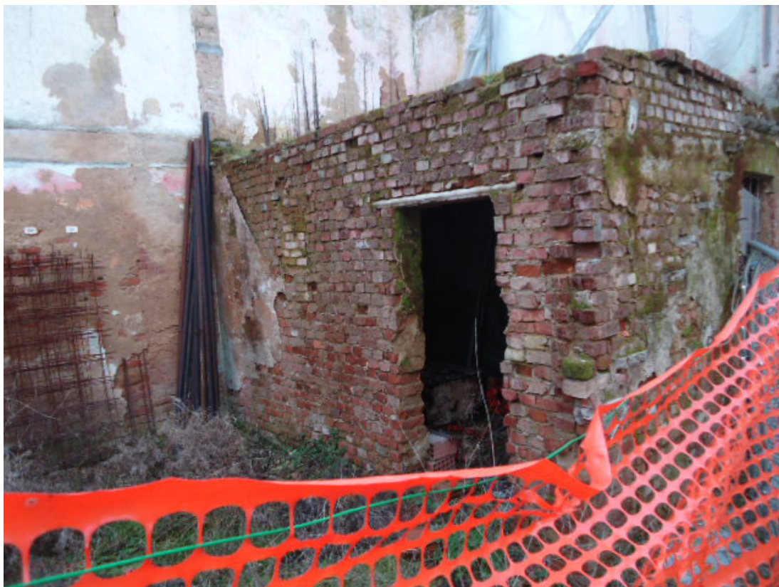
Particolare del rudere del vecchio fabbricato quasi completamente demolito.
