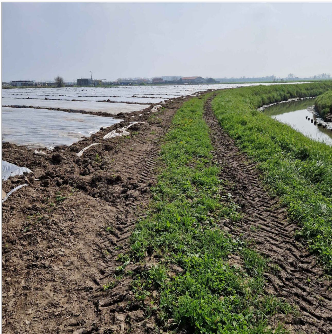
FOTO N°3- VISTA DA NORD
