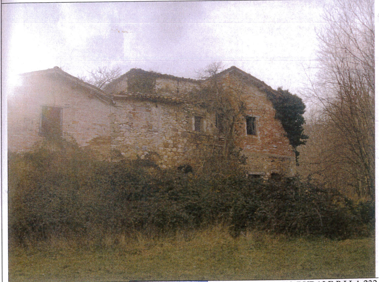
FABBRICATO RURALE P.LLA 232
