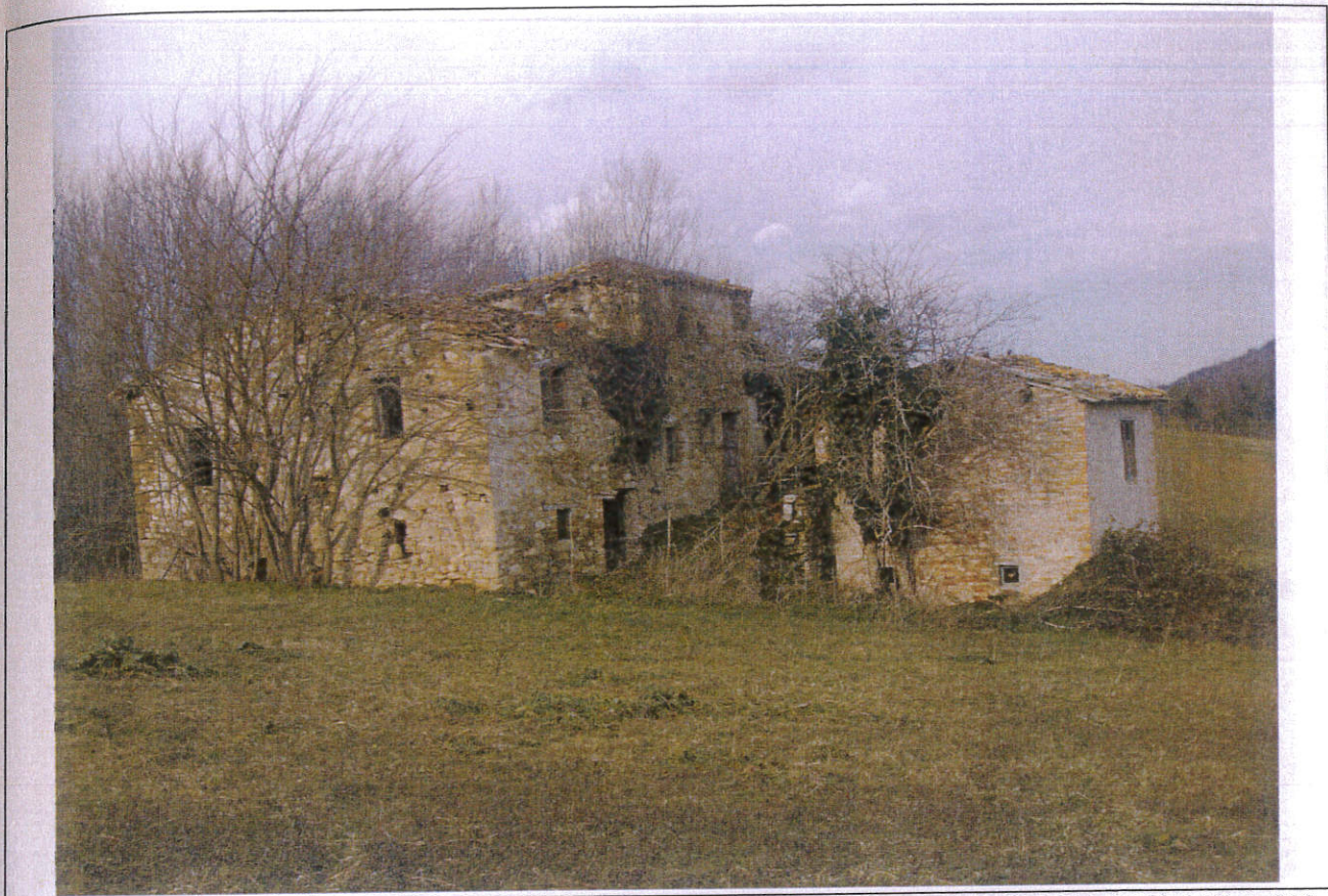
VISTA FABBRICATO RURALE P.LLA 233
