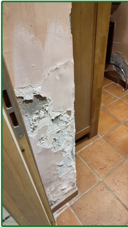
Danni da infiltrazioni - piano seminterrato
