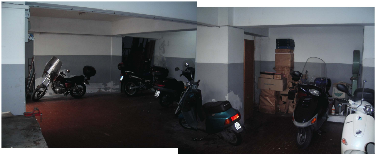
Magazzino in via primo Noviziato, Messina. Vista degli ambienti interni, ad oggi utilizzati come garage condominiale.
