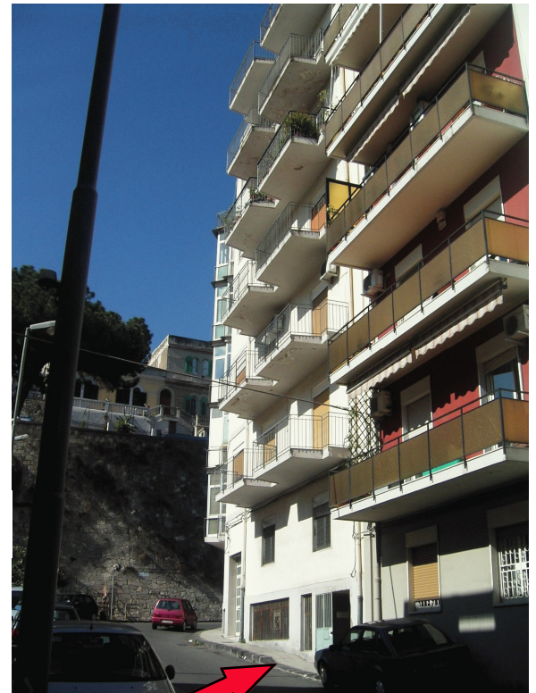
Magazzino in via primo Noviziato, Messina. Edificio al cui piano seminterrato si trova il deposito d'interesse.
