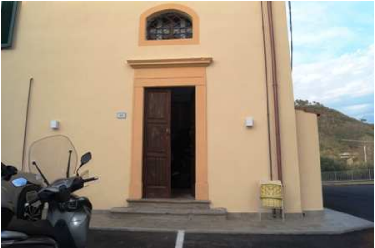
Prospetto principale lato ovest
