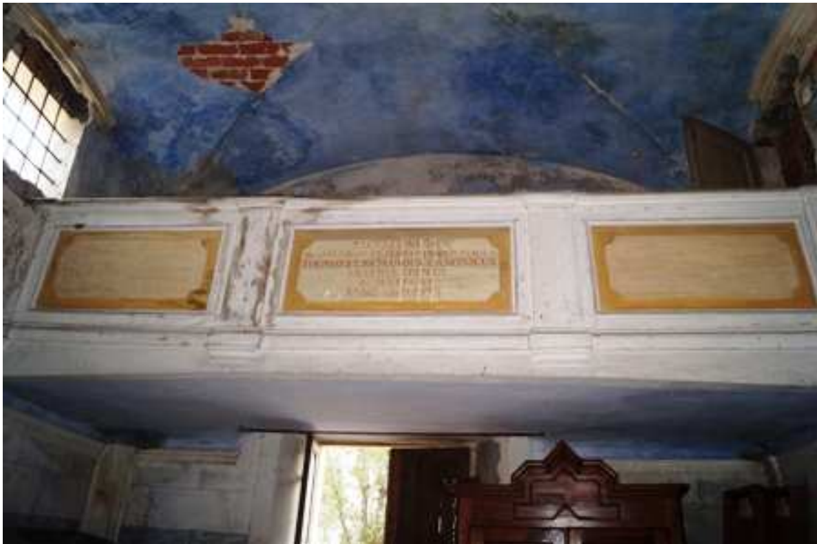
Particolare del soppalco
