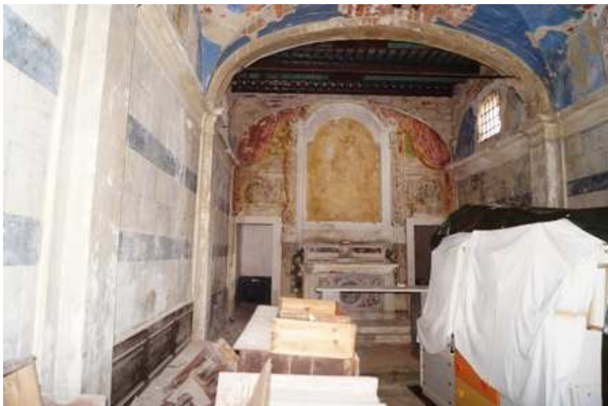
Foto interna dal portone d'ingresso
