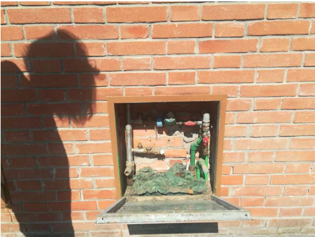
UNICO VANO CONTATORI ACQUA
