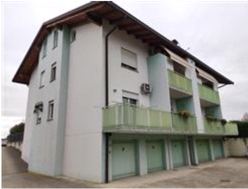
particolare prospetto sud-ovest
