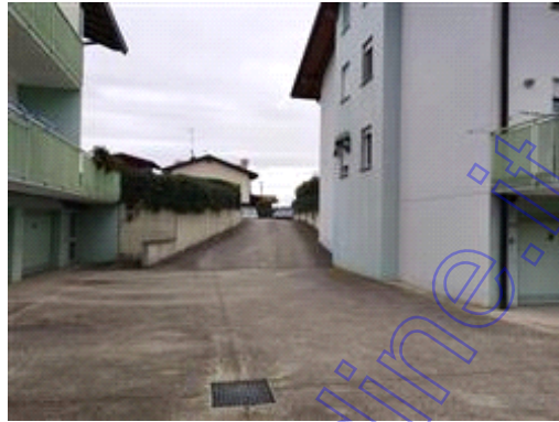
particolare accesso alle autorimesse
