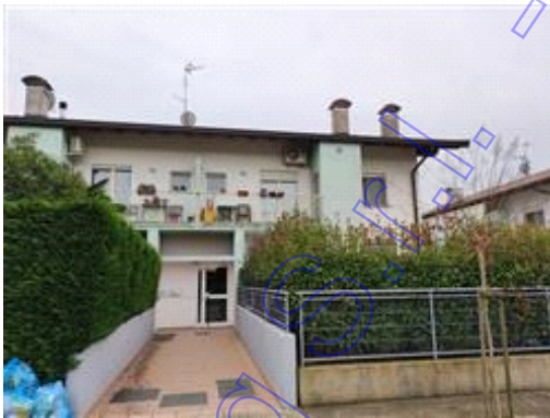
particolare prospetto nord
