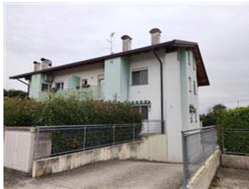
particolare prospetto nord-ovest
