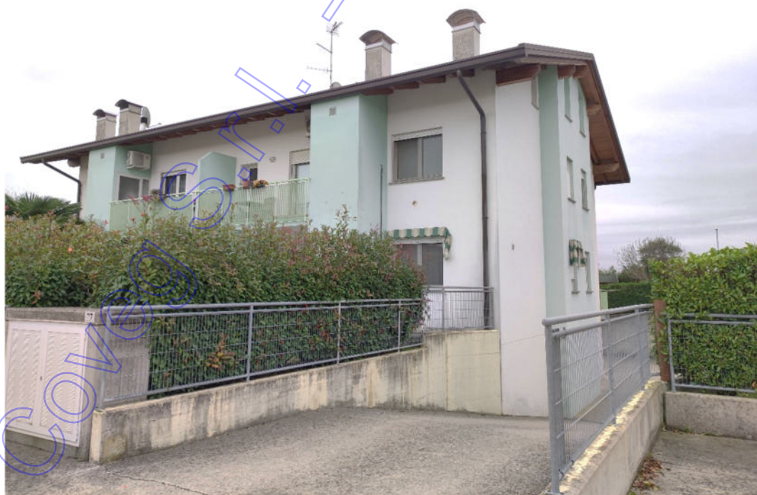
particolare prospetto nord-ovest
